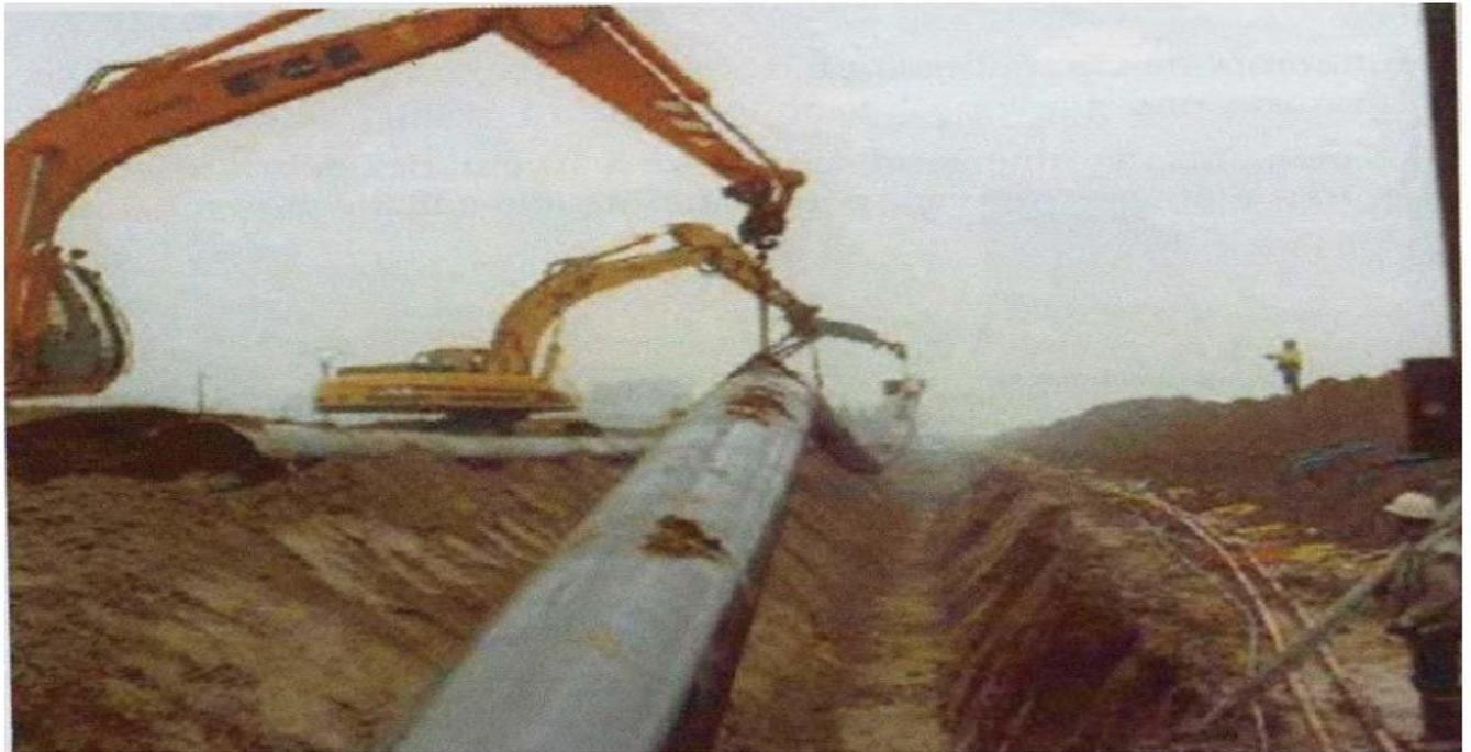
**Figure V.2: pose des conduites en PE dans les tranchées**
