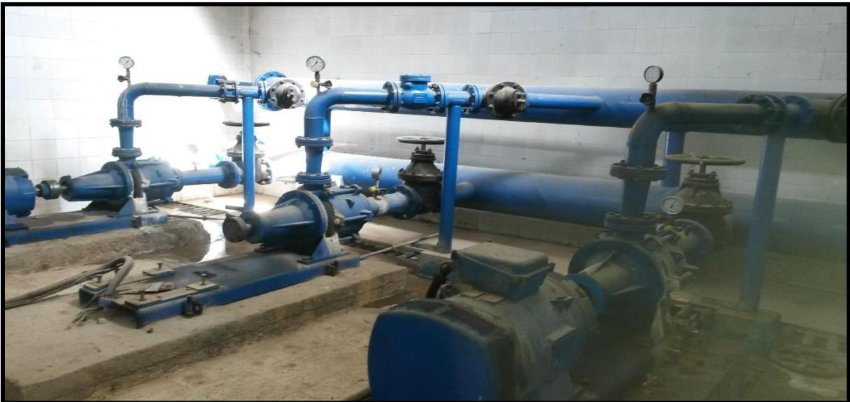
**Figure I-10 : Vue à l'intérieur de la station de pompage (groupe électropompe)**
