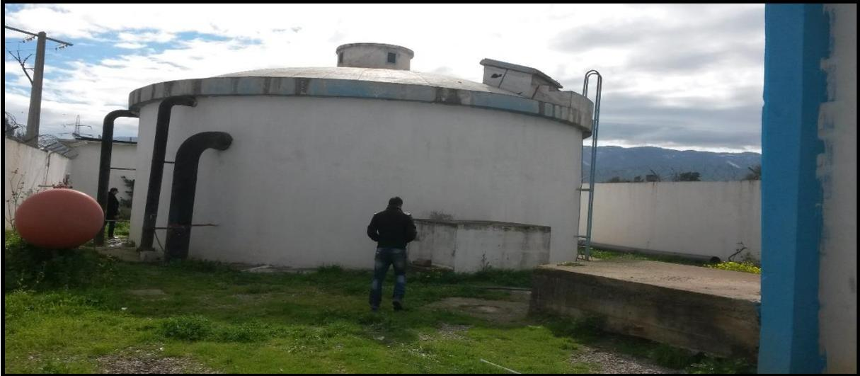
**Figure I-11 : Bâche de capacité de 500 m<sup>3</sup> de la station de pompage**
