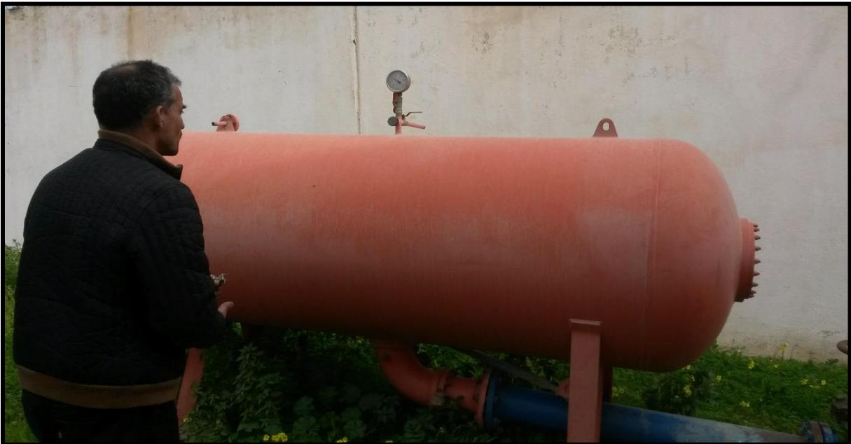
**Figure I-12 : Réservoir anti bélier 2000 l de la station de pompage**
