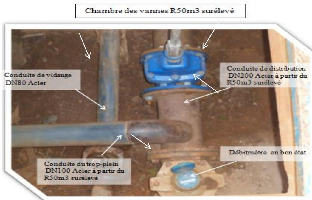
Figure II 9. chambre des vannes R50m<sup>3</sup> surélevé (Source :DRE)
