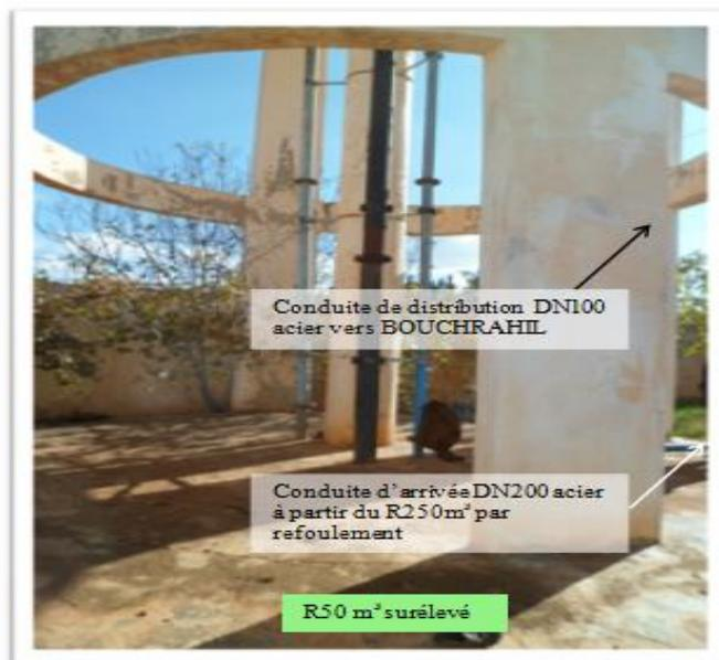
Figure II 8. réservoir surélevé 50m<sup>3</sup>(Source :DRE)
