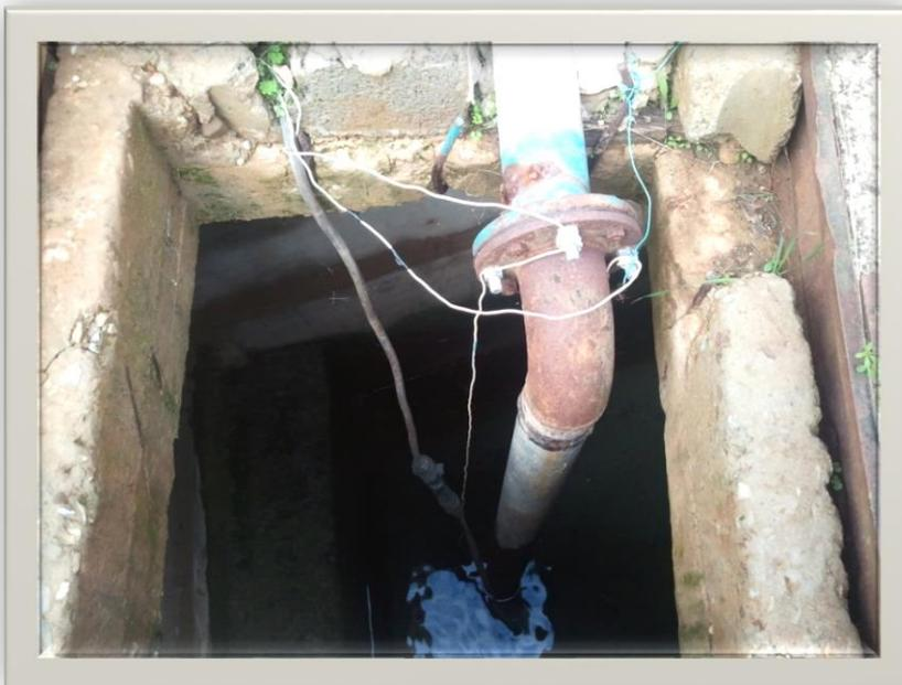
Refoulement par pompe immergée dans l'ouvrage de captage
