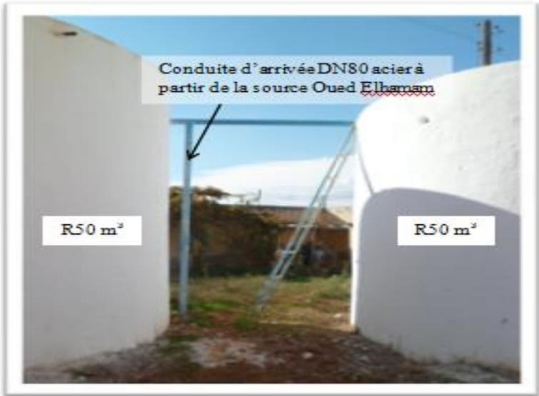
Figure II 7.vue de près du réservoir 2\*50 (Source :DRE)
