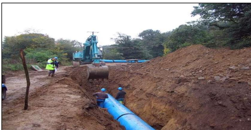
Figure VIII. 1. Pose de conduite dans un terrain ordinaire (Source : groupe-lauriere.com/références-ouvrages/groupe-laurière).
