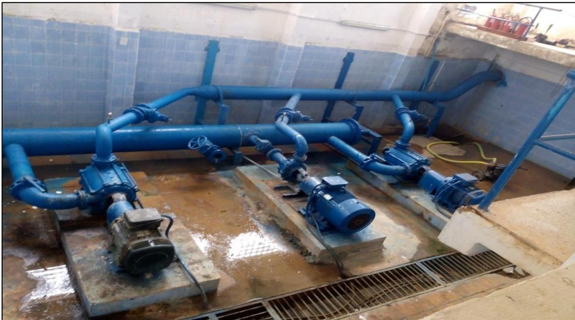
Figure II. 1 Groupe électropompes dans la station de pompage MITIDJA OUEST (17/08/2017)
