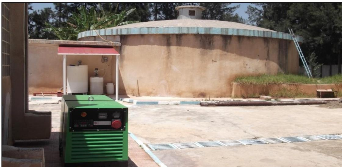
Figure II. 2. Réservoir 500 m<sup>3</sup> et le javelisateur (17/08/2017)
