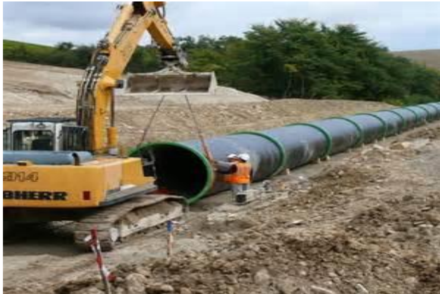
Figure VI.2 : pose des canalisations en fonte en tranchée.
