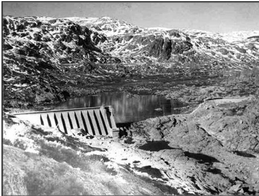
Figure I .6: Barrage de Vega de Tera après la rupture.
