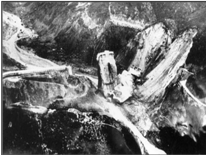
Figure I .10: Barrage de St. Francis après la rupture.
