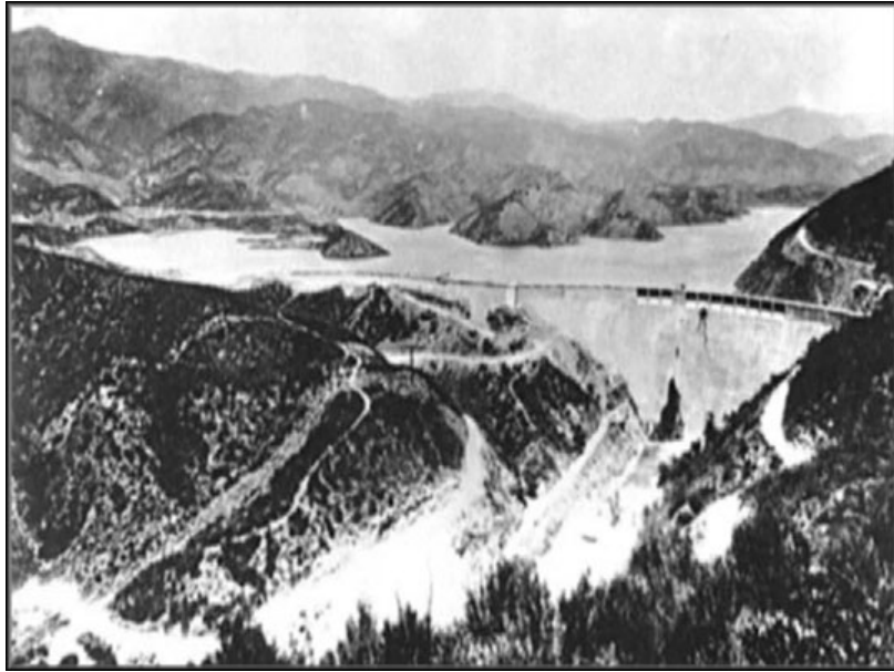
Figure I .-9: Barrage de St. Francis avant la rupture.
