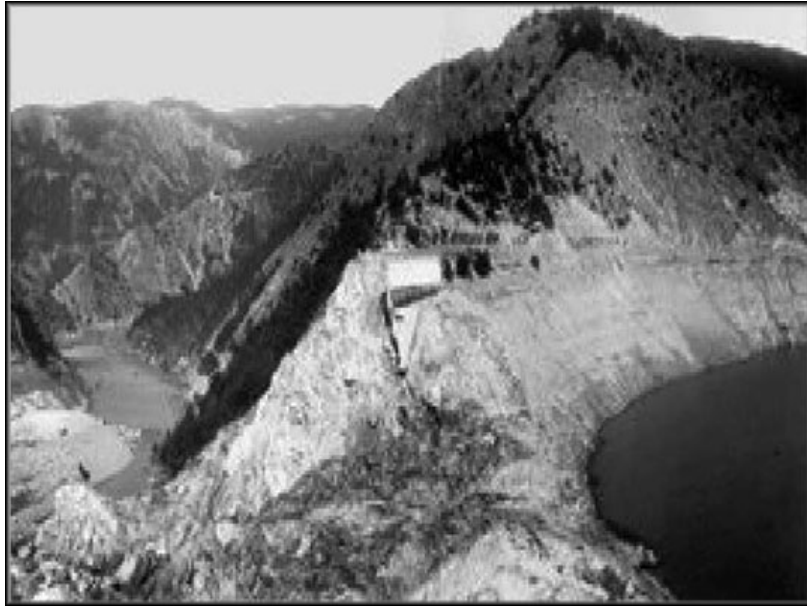
Figure I .12: Le barrage de Sella Zerbino après la rupture.
