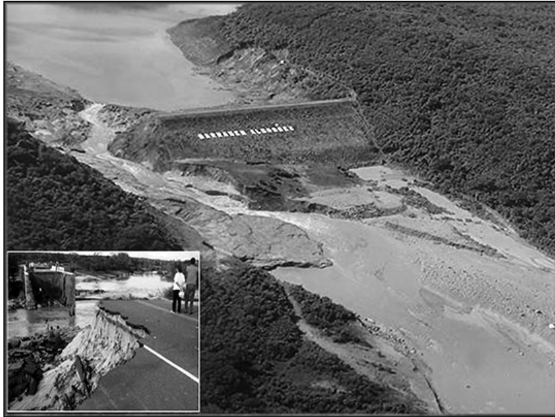
Figure I .16: Barrage de Algodoes après la rupture.
