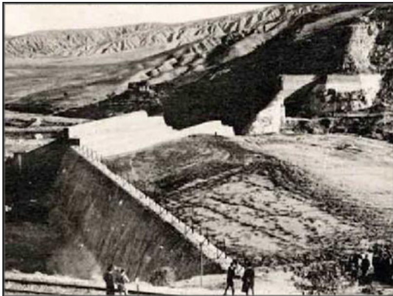
Figure I .13: Barrage de l'Habra, première rupture en 1881.
