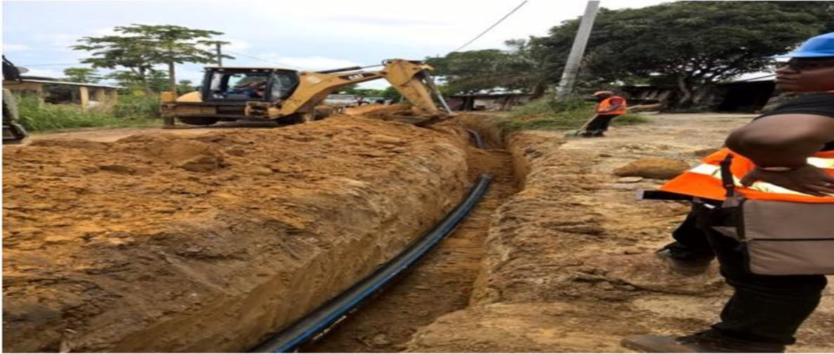
**Figure VII.6 :** pose des canalisations en PEHD en tranchée.
