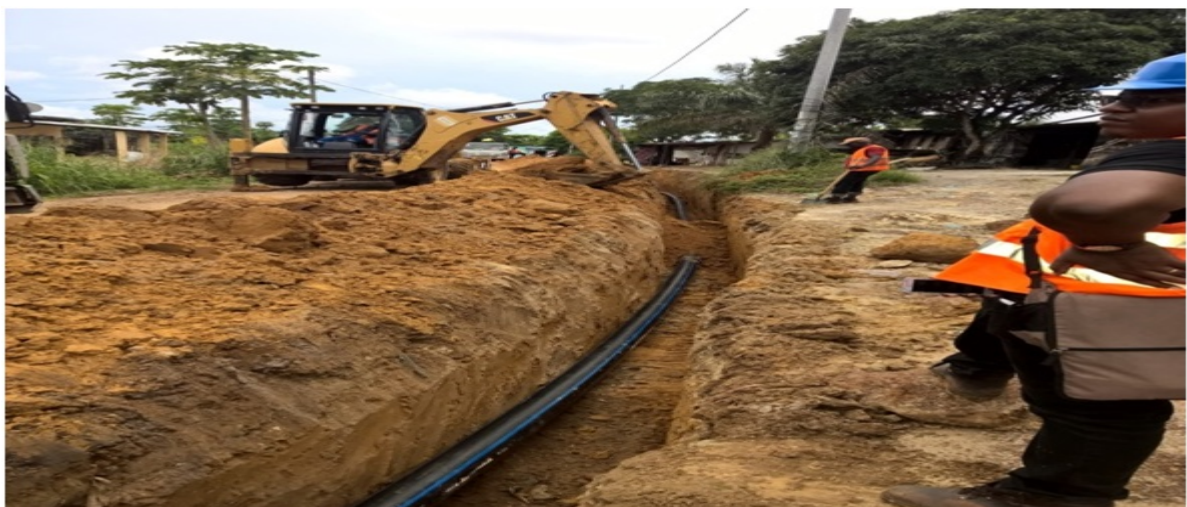
Figure VI.2 : pose des canalisations en PEHD en tranchée.
