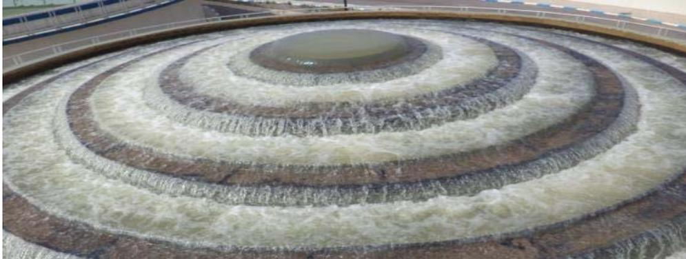
**Figure II.3** : Cascade d'aération
