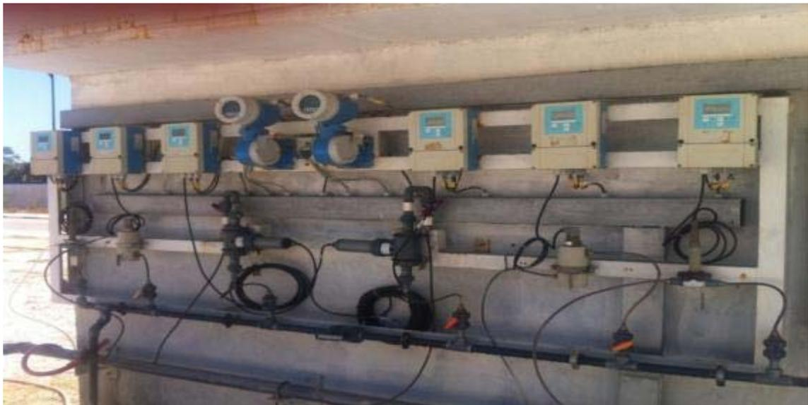
**Figure II.2 :** Appareillage de mesure d'eau brute
