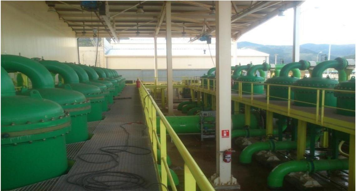
Figure II-4 : Photo des filtres à cartouches
