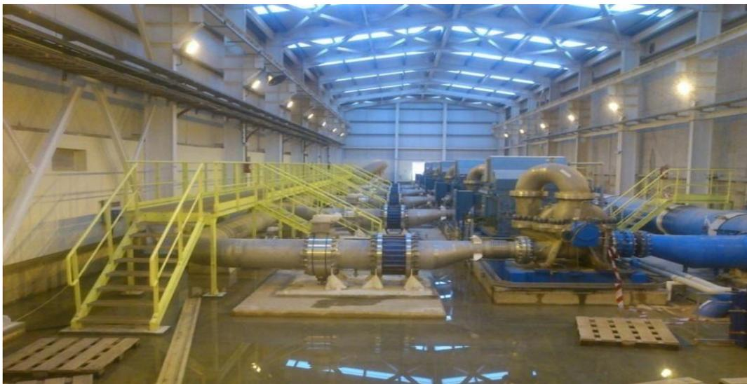
**Figure II-8 :** Photo Station de pompage d'eau produite (4 pompes et 1 secours)
