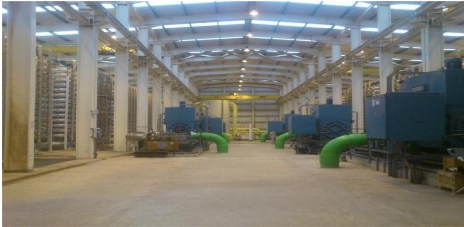
**Figure II-6 :** Photo de la chambre de pompage - Osmose inverse
