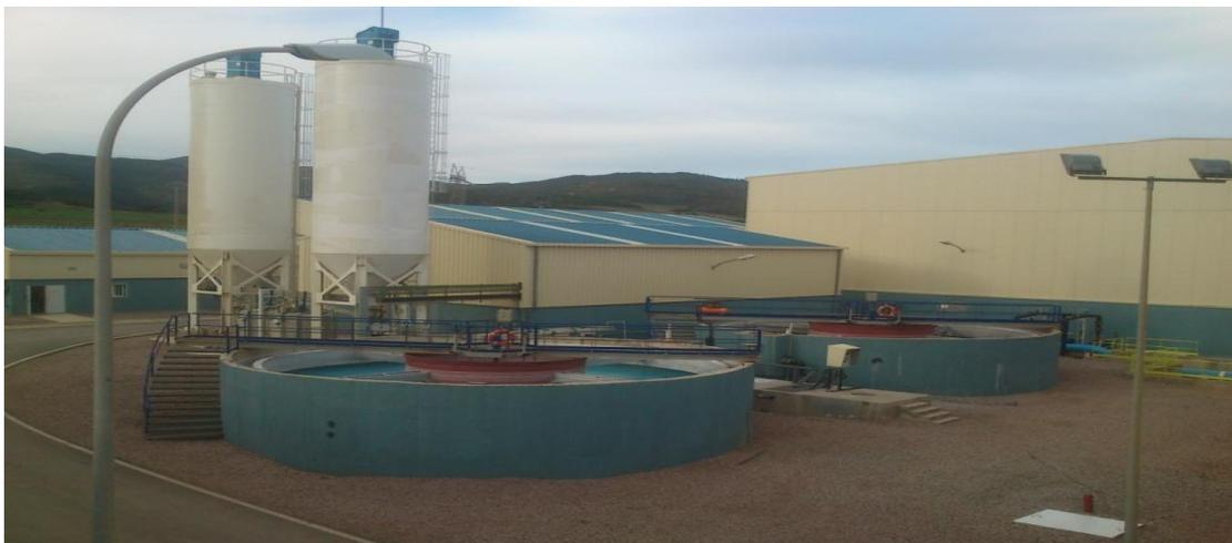
**Figure II-7** : Photo reminéralisation : Saturateurs de chaux
