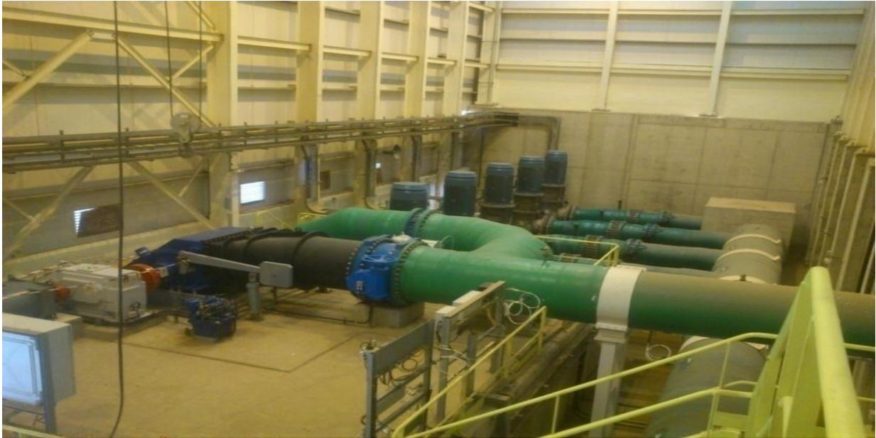
**Figure II-2** : photo des pompes d'impulsion (4 +1)
