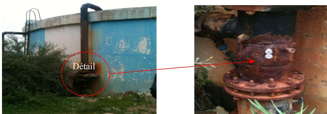
**Figure III-4** : photo du réservoir d'Ain arnet (à gauche) et état de la vanne de sectionnement sur la conduite d'alimentation (à droite). (DRE setif,2015)
