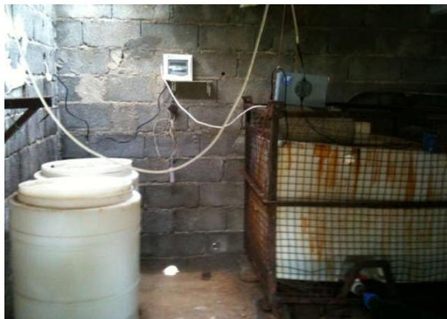
Figure III-2 : Procédé de javellisation du réservoir d'Ain arnet (DRE setif ,2015)
