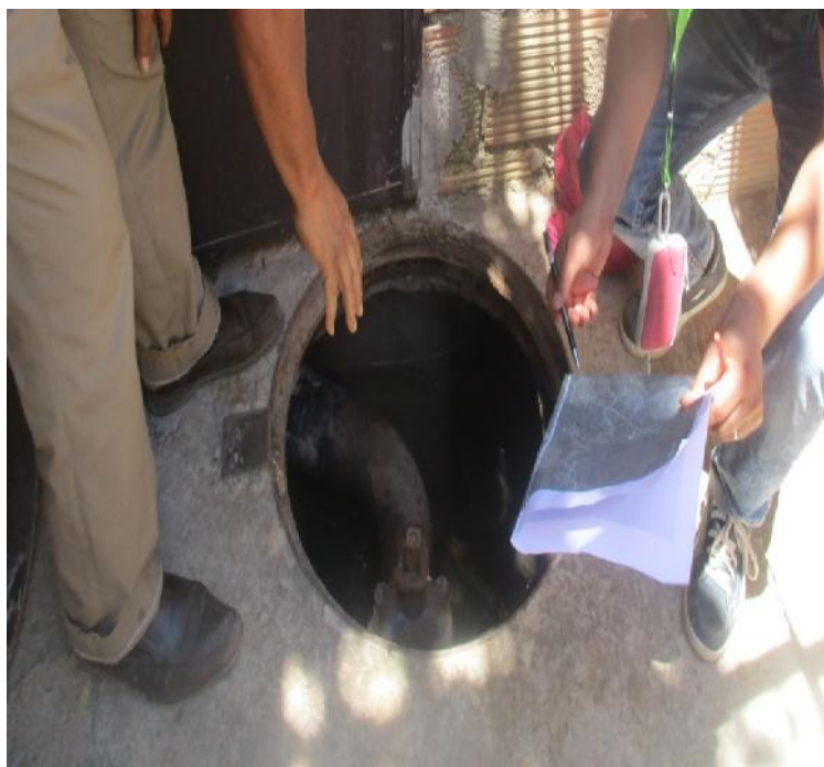
Figure3.12: Regards de vanne de 80mm qui est passée par maisons des Habitants
