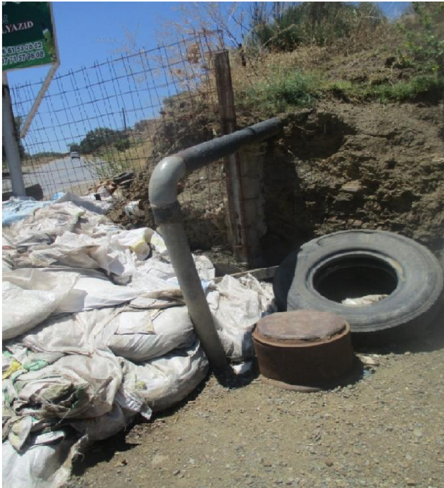
Figure3.11 :Conduite en acier de D120mm passée dans ce quartier
