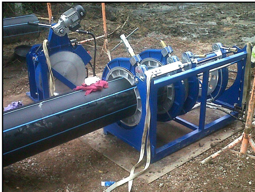
Figure V. 5 : Raccordement par machine de soudure bout à bout
