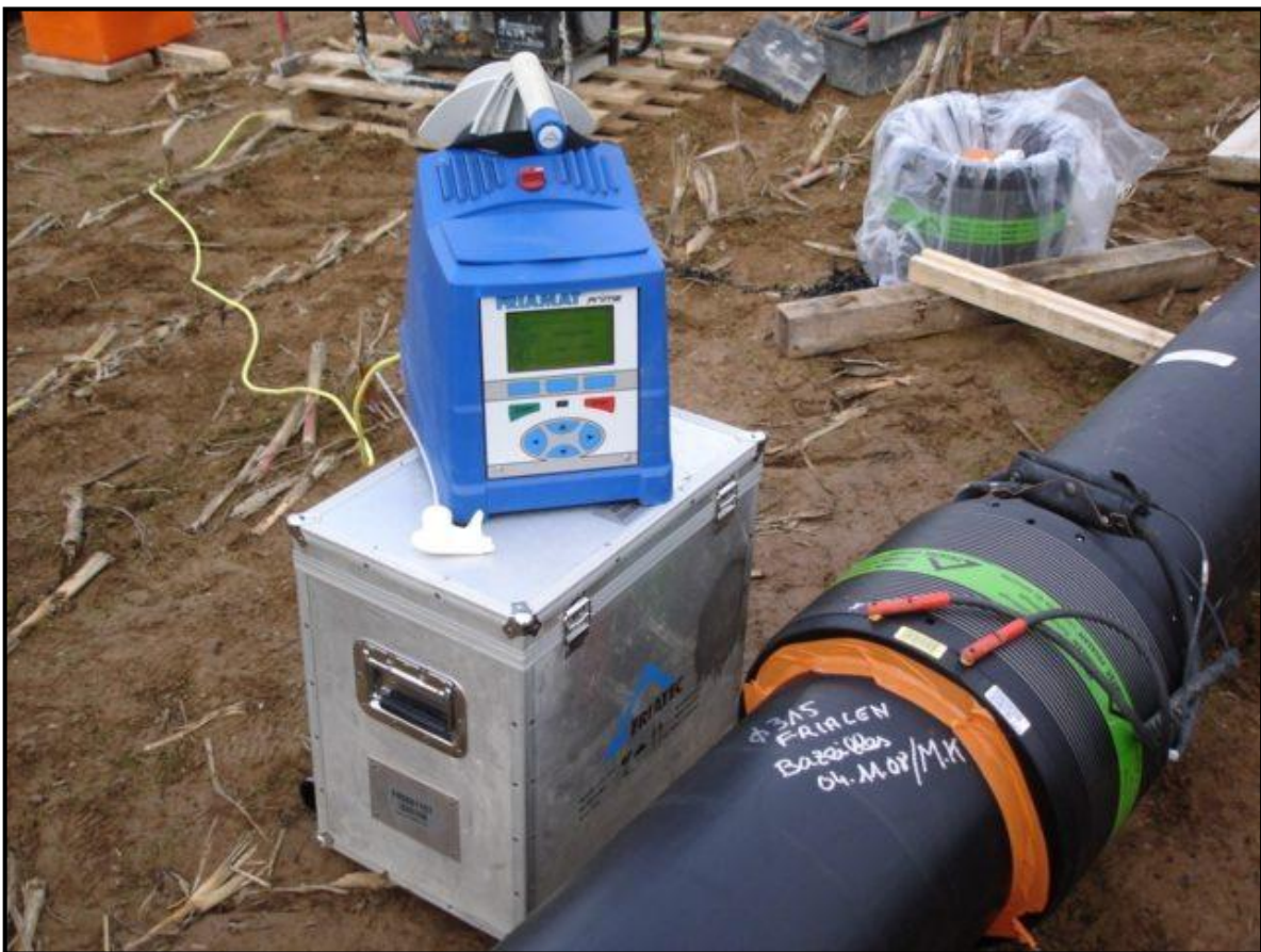
Figure V. 6 : Raccordement par groupe électro-soudables
