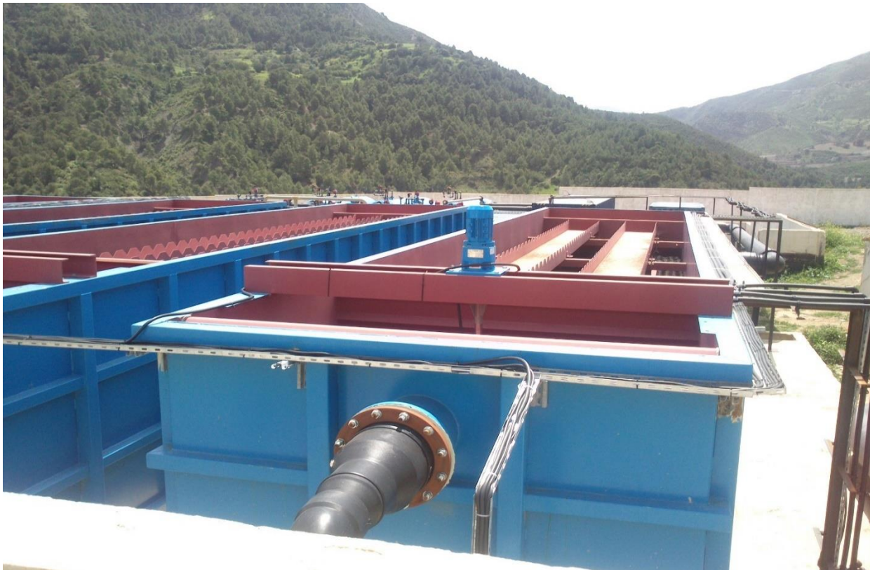
Figure III- 8 Photo d'un bassin de décantation
