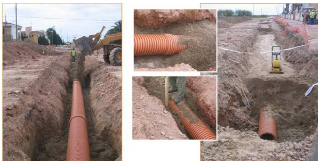
Figure VII- 2 Pose des canalisations en plastique
