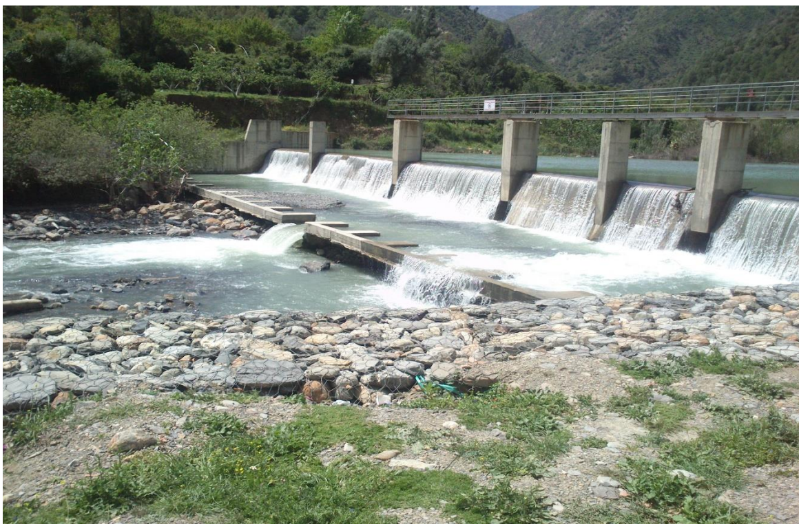
Figure III- 2 Photo du barrage de Magtaa lazrag
