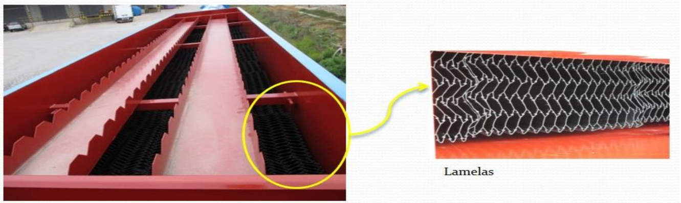
Figure III- 7 Photo d'un bassin de décantation (source : formhyd)
