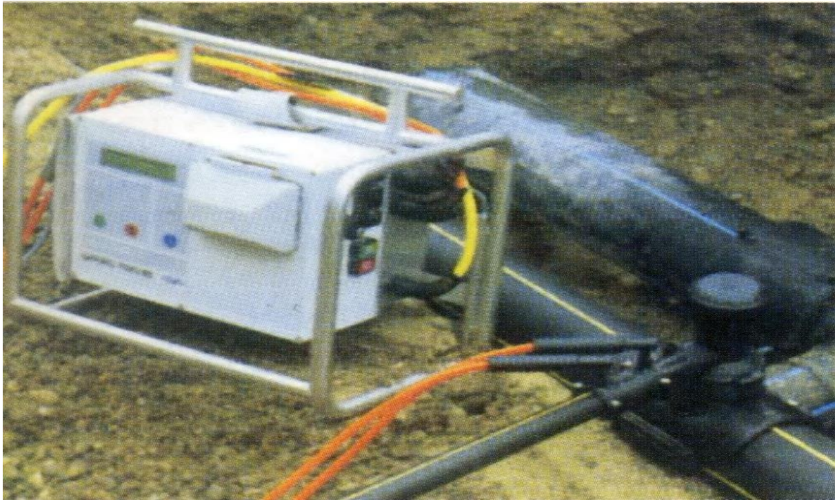
Figure VI.16: Raccordement par accessoires électro-soudables [18]
