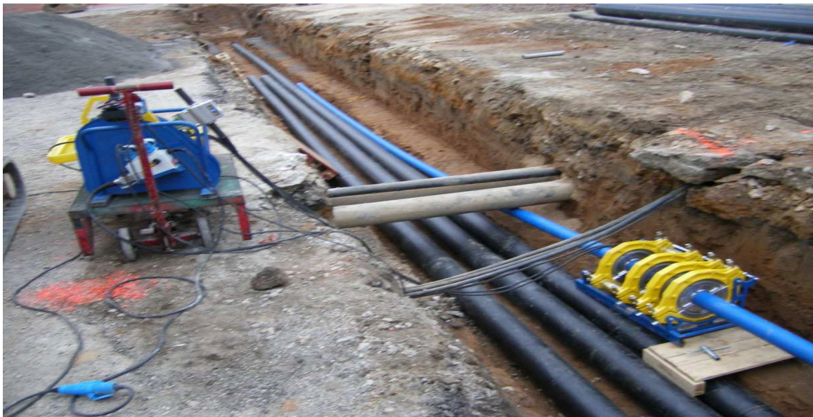
Figure VII.4 : pose des conduites en PE dans les tranchées.
