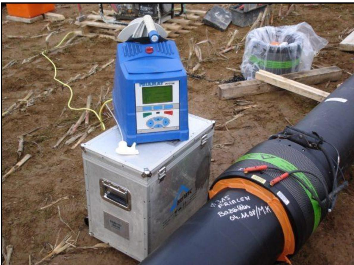
Figure V. 6 : Raccordement par groupe électro-soudables
