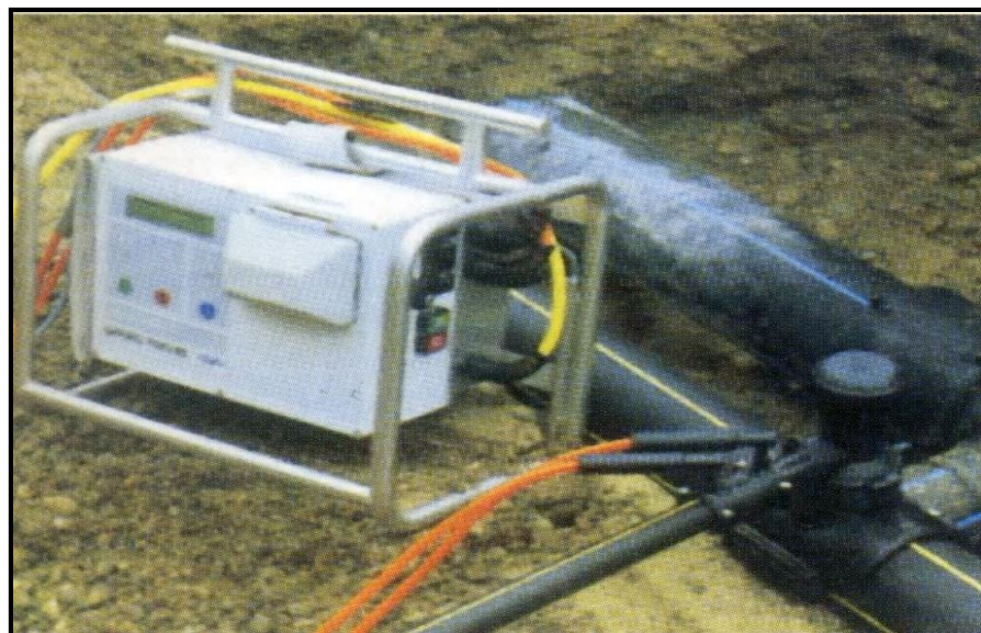
Figure VI-5: Raccordement par accessoires électro-soudables.
