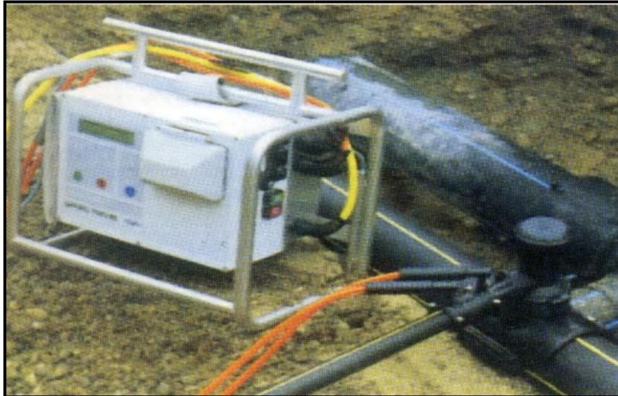
Figure V.12 : Raccordement par accessoires électro-soudables
