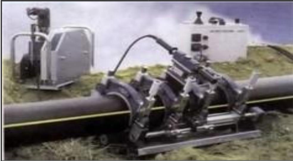
**Figure V.11 : Bout à bout « bouseuse »**
