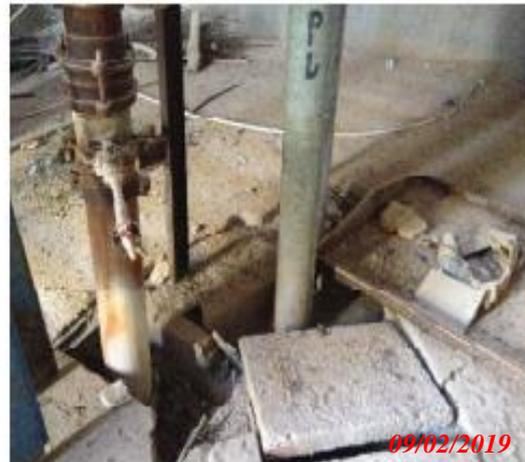
*Figure II.80: Dégradation de la plateforme*
