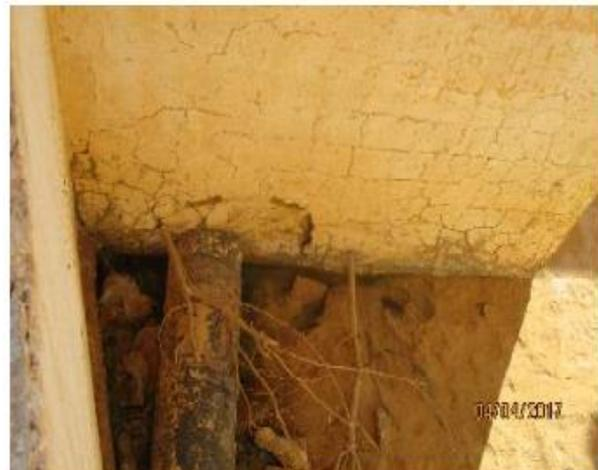
**Figure II.38:** Dégradation des parois coté extérieur dû au réservoir
