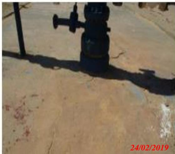
**Figure II.63:** Fissuration au niveau de la plateforme
