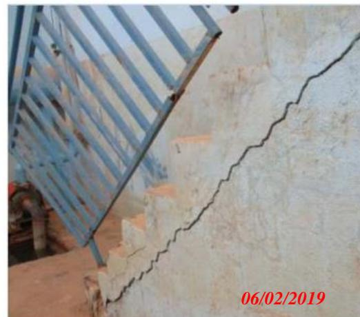
**Figure II.52:** Dégradation des escaliers et détachement du garde-corps.
