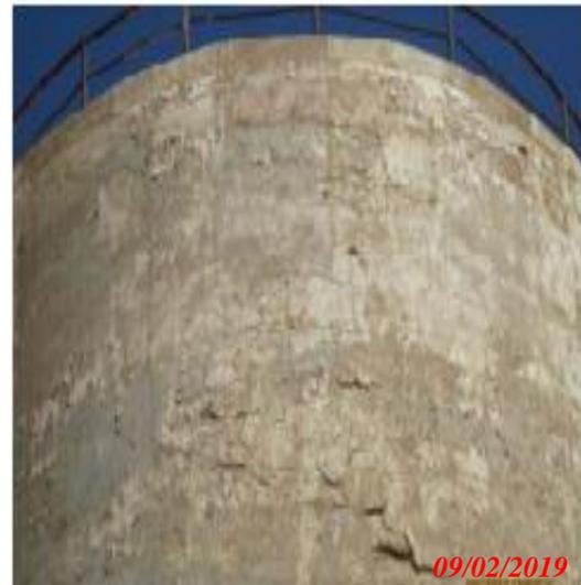
**Figure II.69 :** Dégradation de l'enrobage
