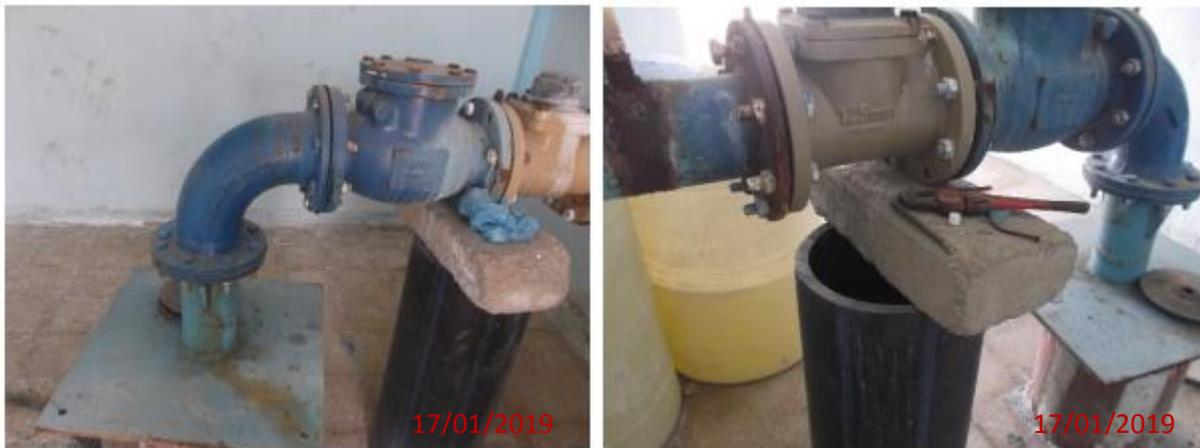
*Figure II.6 : le support au niveau de forage est fragile*
