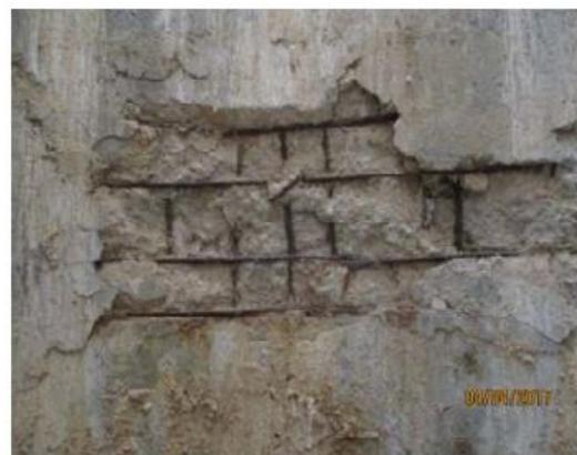
**Figure II.49 :** Dégradation de l'enrobage avec apparition
