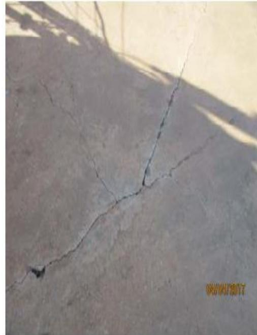
**Figure II.46:** Fissuration sur la dalle de couverture, avec absence d'étanchéité.
