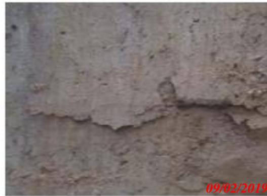
**Figure II.71:** Présence d'humidité apparente sur les parois extérieures de la cuve
