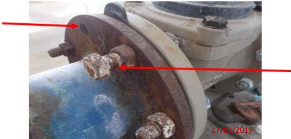
*Figure II.4 : l'absence des boulons de fixations.*
