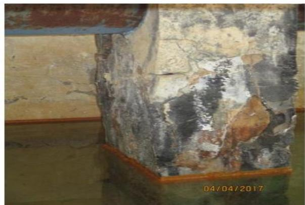
**Figure II.40 :** Dégradation du socle avec présence d'eau
