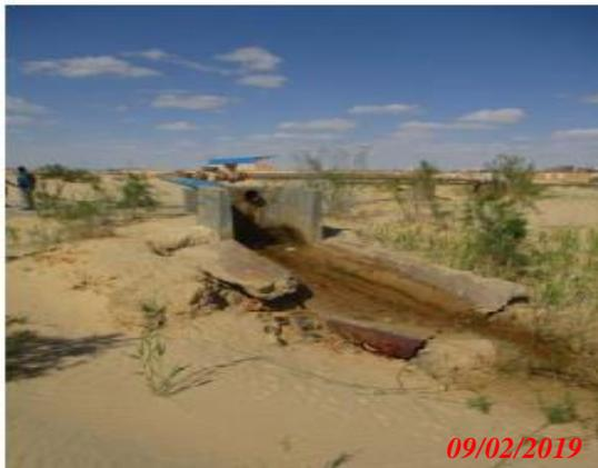
**Figure II.73:** Canal de rejet dégradé
