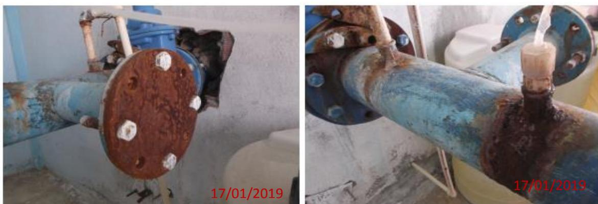
**Figure II.3 : Les boulons du compteur oxydés**
