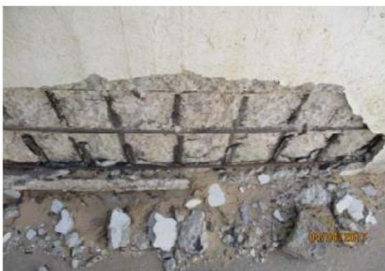
**Figure II.48:** Dégradation de l'enrobage et acier corrodé apparente sur paroi extérieure
