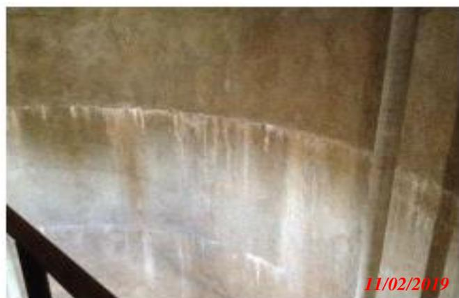
**Figure II.78:** Trace de fuite au niveau de reprise de bétonnage
