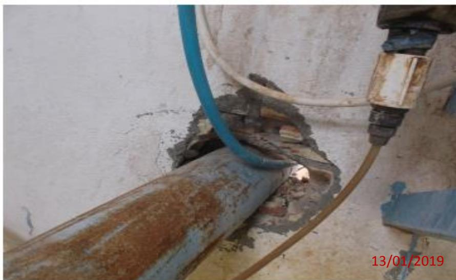
*Figure II.20: une ouverture au niveau du passage de la conduite.*
