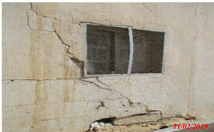
**Figure II.55 :** Dégradation de mur en maçonnerie
