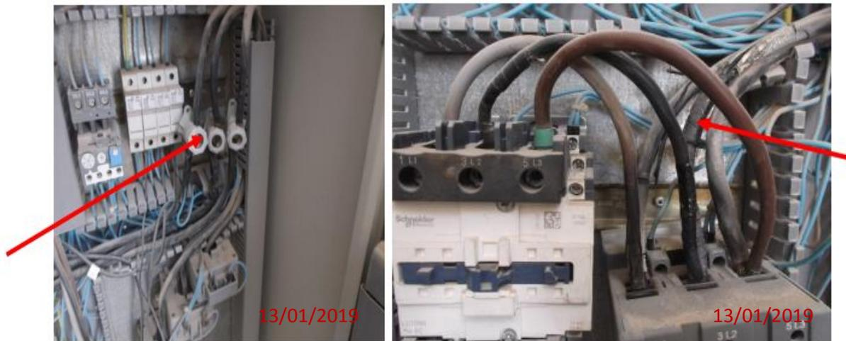
**Figure II.17:** les câbles électriques sans aucune protection mécanique
