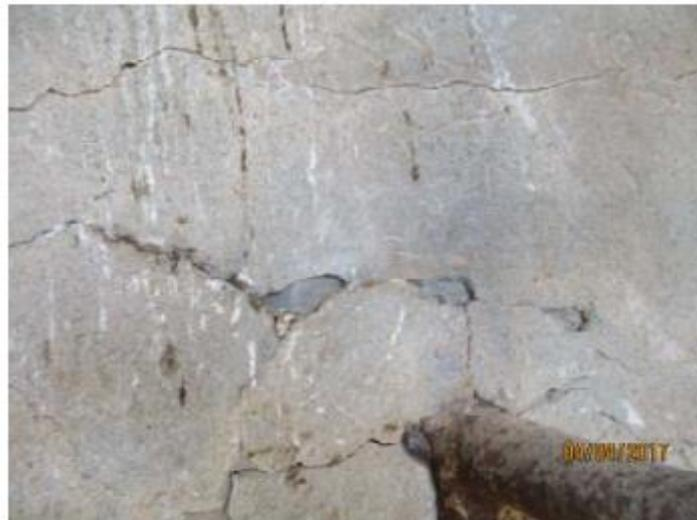
Figure II.50: Dégradation de l'enduit au ciment
