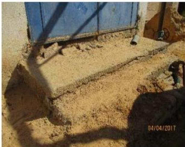
**Figure II.41 :** Etat dégradé des escaliers d'accès à la porte
