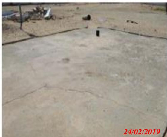
**Figure II.65:** Fissuration au niveau de la plateforme forage.
