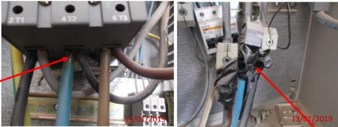
*Figure II.19 : les câbles électriques sans aucune protection mécanique*
