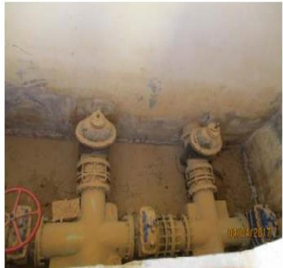
**Figure II.36 :** Présence d'humidité sur la face intérieure des parois de la 1ère chambre
