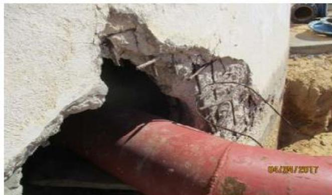
**Figure II.47 :** Réserve pour conduite prévu non conforme
