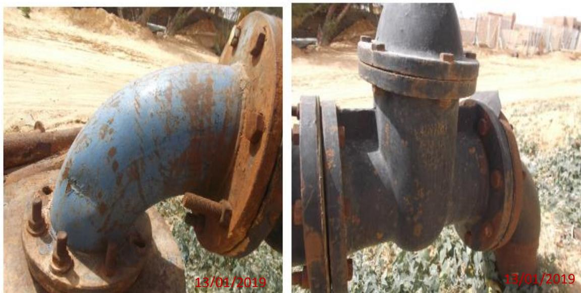
*Figure II.14 : l'oxydation et peinture du forage.*
