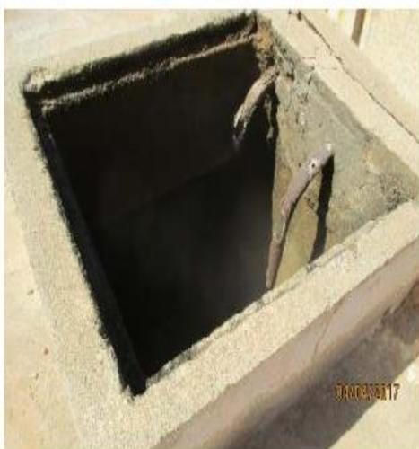
**Figure II.43:** Absence de couverture, et échelle
