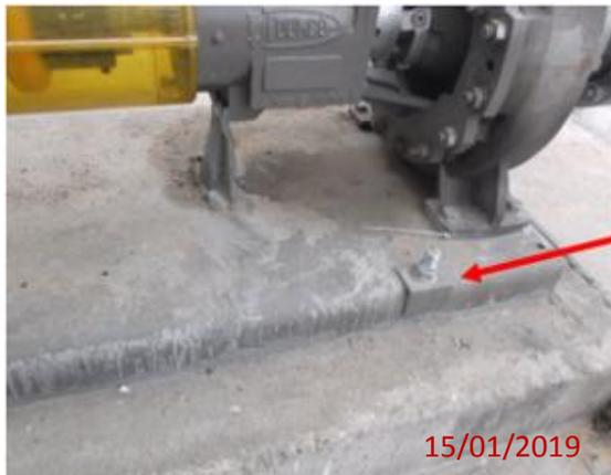
**Figure II.24:** Les tiges de fixation des GEP
