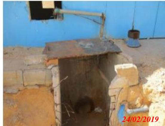
**Figure II.54 :** Dégradation de regard de conduite
