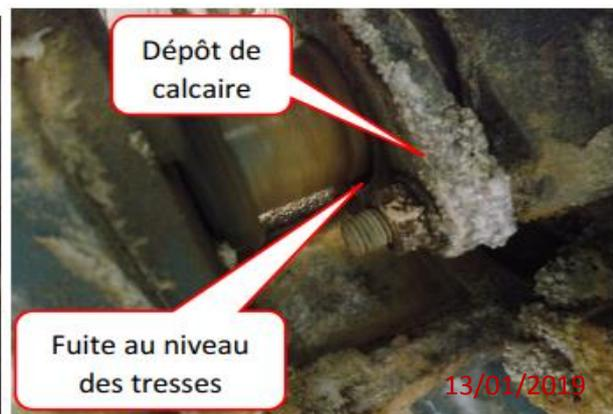
**Figure II.30 :** fuite et dépôt de calcaire au niveau des tresses
