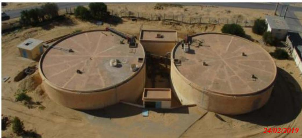
**Figure II.34:** Vue des réservoirs 2x3000 m<sup>3</sup> [Source : ADE Touggourt]
