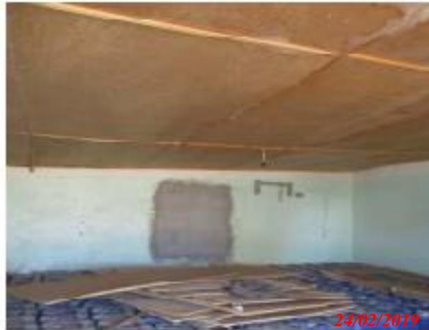
**Figure II.64:** Toiture de l'abri en tôle avec contre-plaqué
