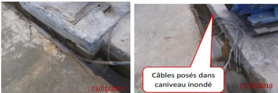
*Figure II.32 : les câbles posés dans caniveau inondé.*
