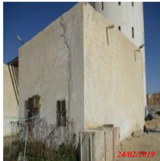
*Figure II.57: les fissurations des magasins*
