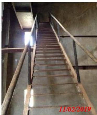
**Figure II.77 :** Escalier métallique d'accès
