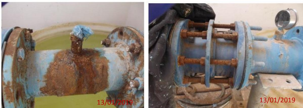
**Figure II.18 :** l'oxydation des équipements
