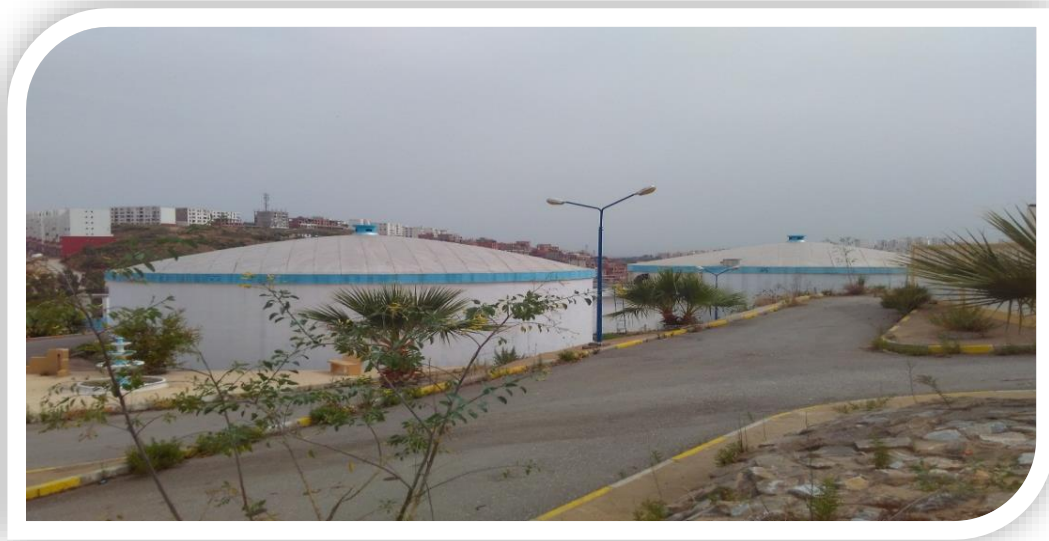
Figure III -5 : La station de pompage Bussedra (DRE Annaba, Mars 2018)
