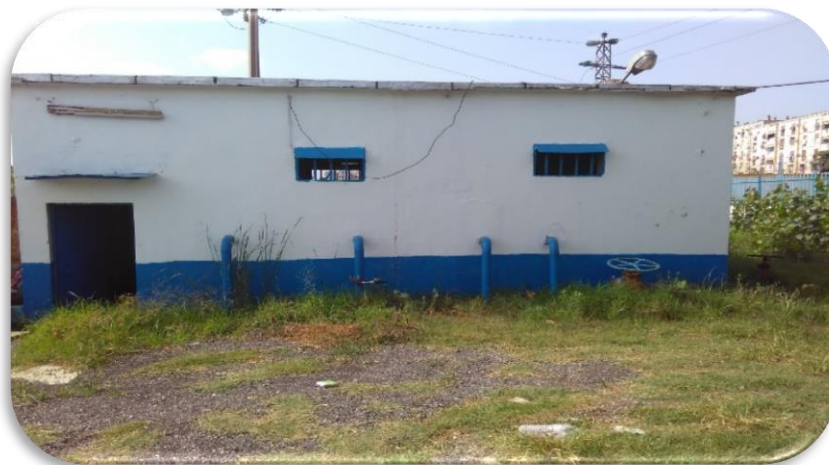
Figure IV.1 : Vue à l'extérieur de la clôture du surpresseur d'El-Bouni centre.
