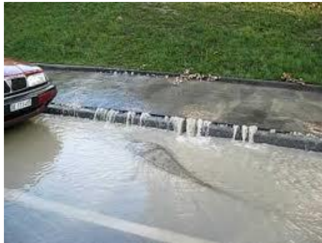
Figure VI.3 : rupture d'une conduite d'eau
