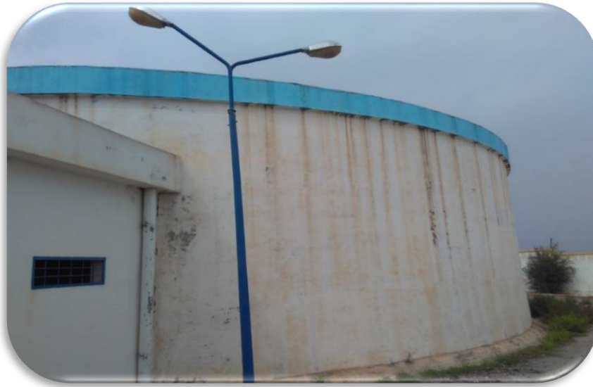
Figure IV.10 : Vue à l'extérieur du réservoir 2000 m 3 (DRE Annaba, Mars 2018)
