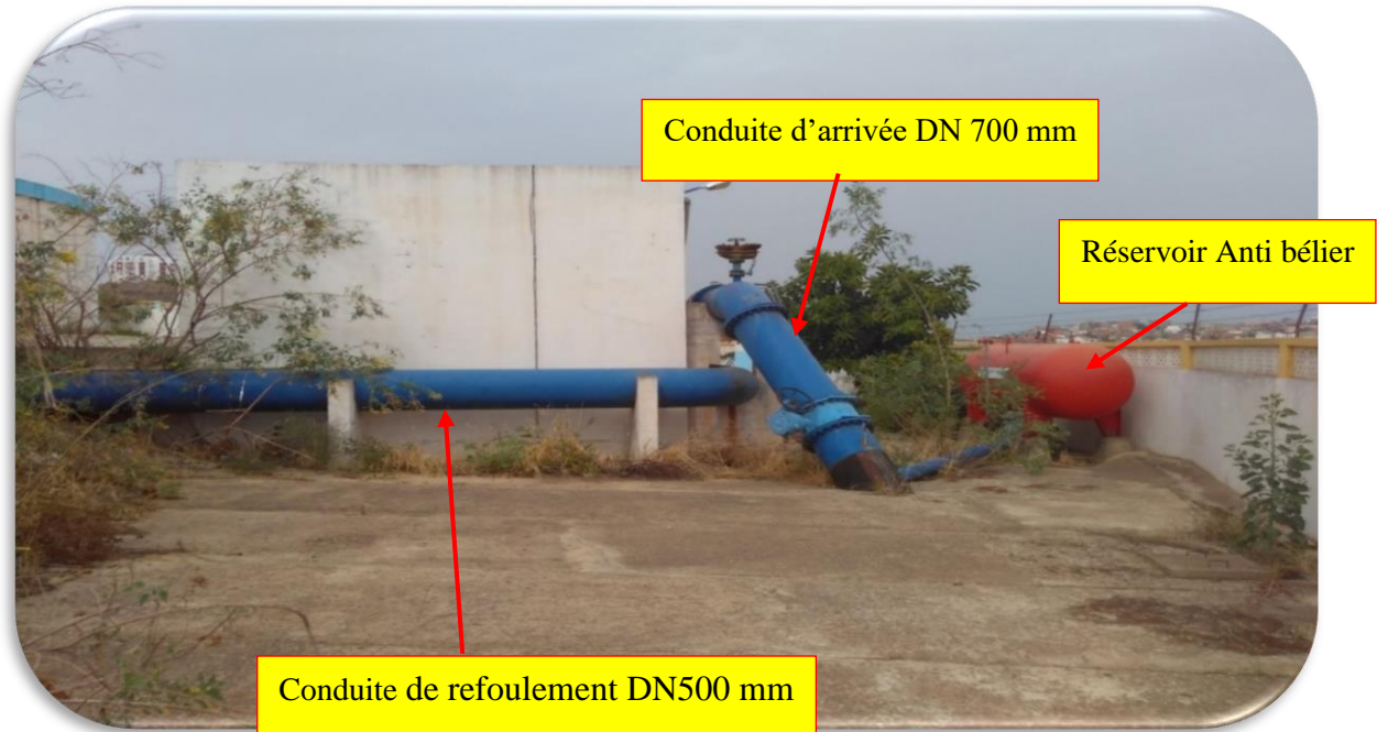
Figure IV.6 : la conduite DN 700 mm et DN 500 mm (DRE Annaba, Mars 2018)
