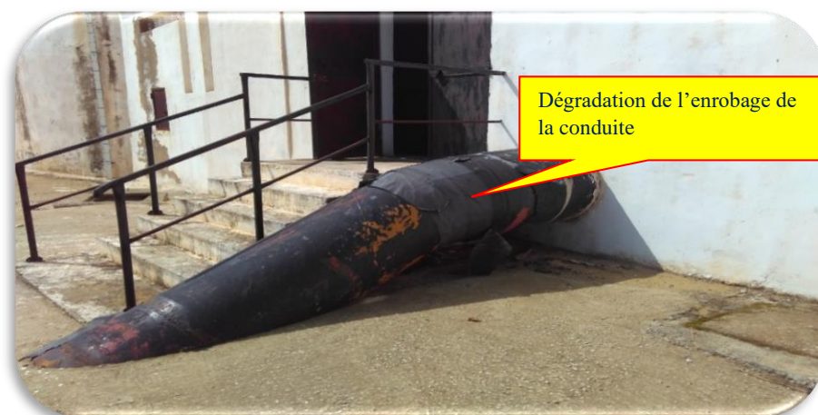
Figure IV.13 : la conduite d'adduction DN 500 mm (DRE Annaba, Mars 2018)
