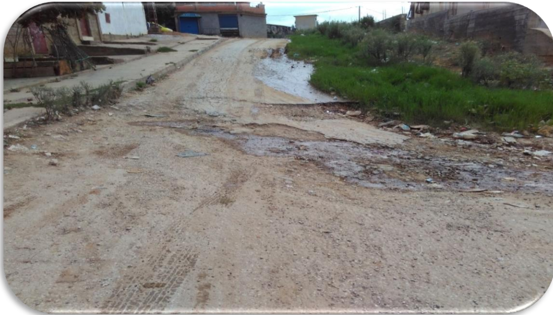
Figure IV.24 : fuite sur la conduite de distribution DN 110 mm en PVC.
