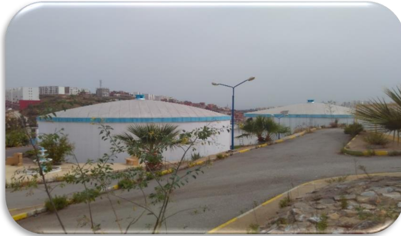
Figure IV.4 : Vue à l'intérieure de la station de pompage Boussedra. (DRE Annaba, Mars 2018)
