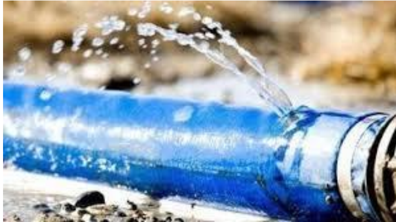
Figure VI.1 : une fuite d'eau.
