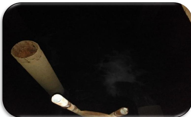
Figure IV.22 : Vue à l'intérieure de la cuve 2000 m 3 (DRE Annaba, Mars 2018)
