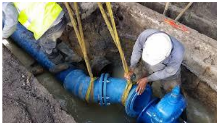
Figure VI.4 : entretien d'une conduite d'adduction
