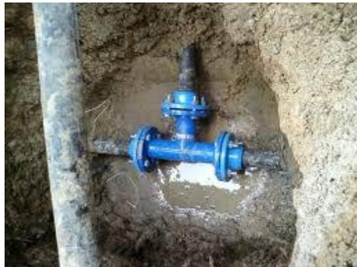
Figure I-5 : les fuites au niveau d'un nœud (raccordement Té)
