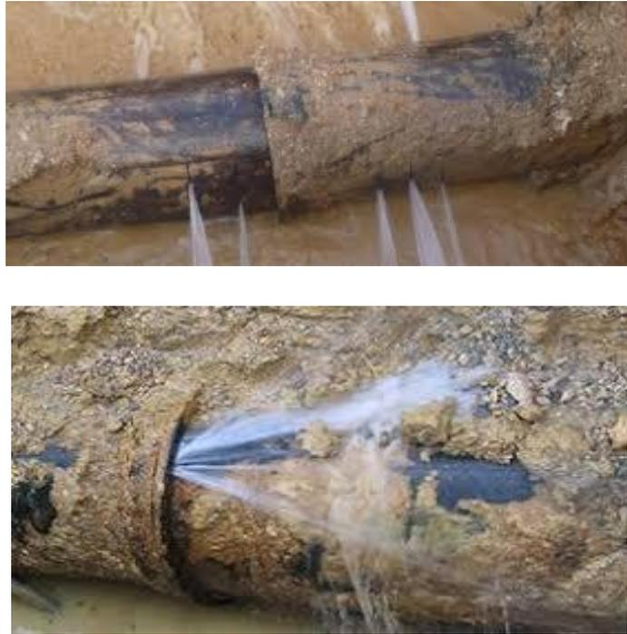
Figure I-4 :les fuites au niveau des joints dans une conduite en PVC du réseau d'alimentation de la ville de Bousseghoun
