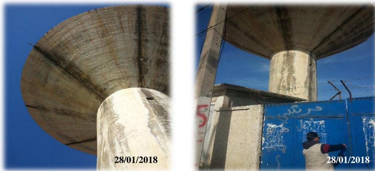
Figure IV.13 : L'état extérieur du réservoir.
