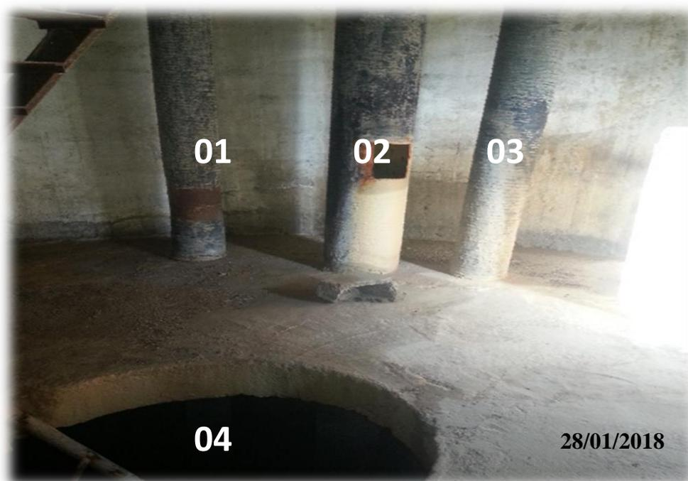
**Figure IV.15:** Etat des conduites du réservoir.
