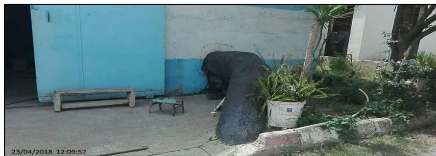
Figure (IV.3) : Vue extérieure de la conduite d'arrivée de la station de Béni-Tamou. [4]
