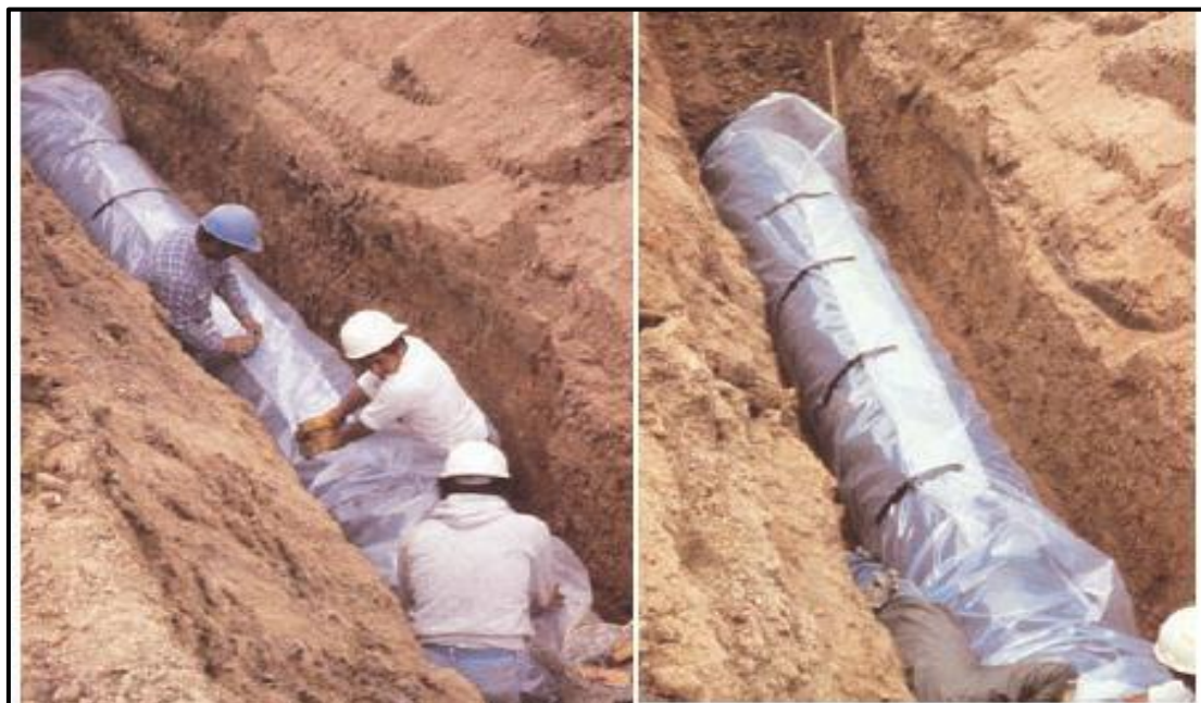
Figure VI.15 : Protection contre la corrosion extérieure avec revêtement en polyéthylène.
