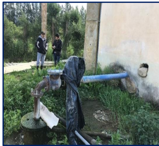
Figure III .3: forage BF4 (Manomètre en panne)
