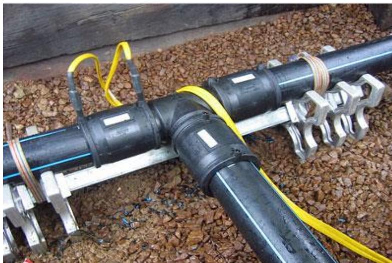
Fig V. 2: Electro soudage des tubes en PEHD
