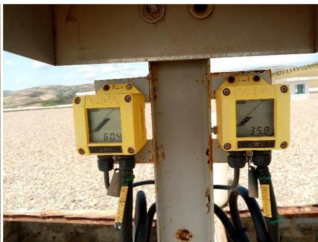
*Fig III. 6: Compteurs du débit 7/7/2020**Fig III. 7: Capteur de niveau d'eau 7/7/2020*
