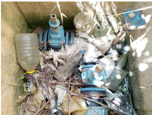
*Fig III. 11: Vanne d'adduction du réservoir
