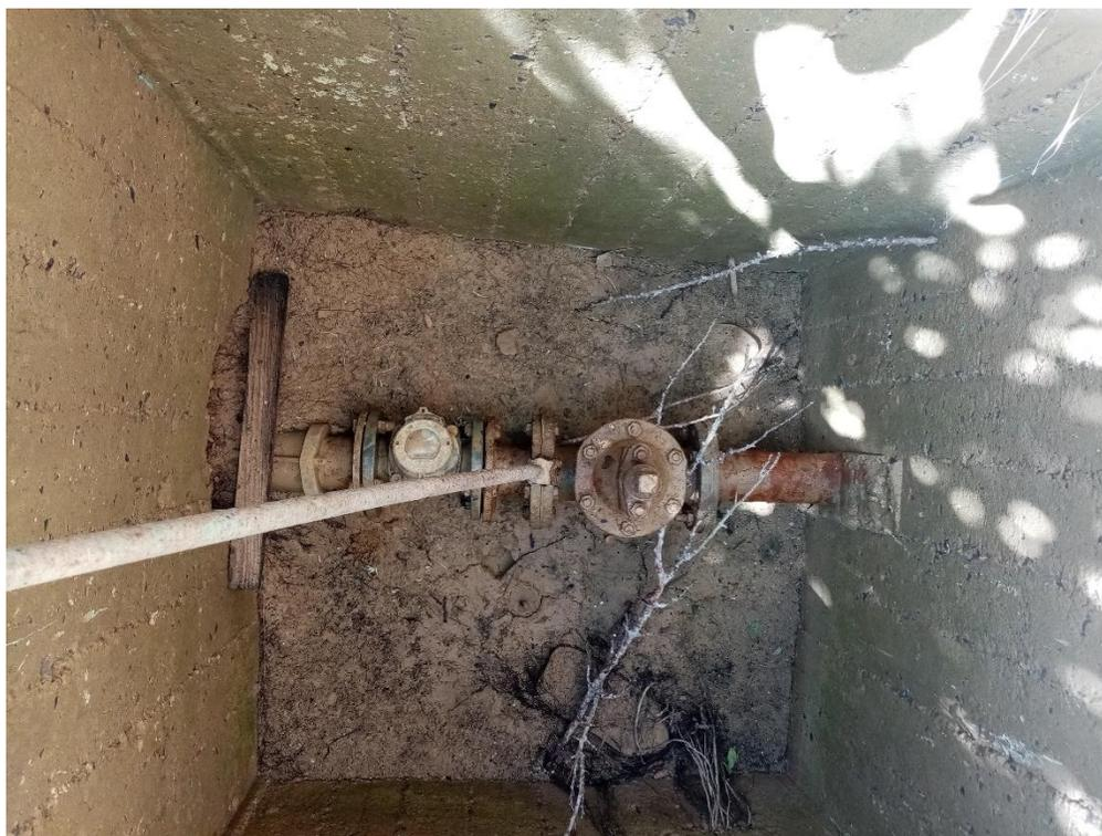
*Fig III. 14: Vanne de distribution du réservoir de Lotissement 5 7/7/2020*
