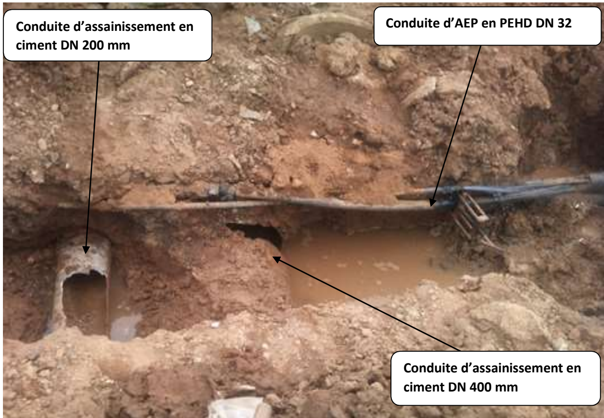
Figure III – 2: état de la conduite DN 32 en PEHD a la cité TAKMILIA
