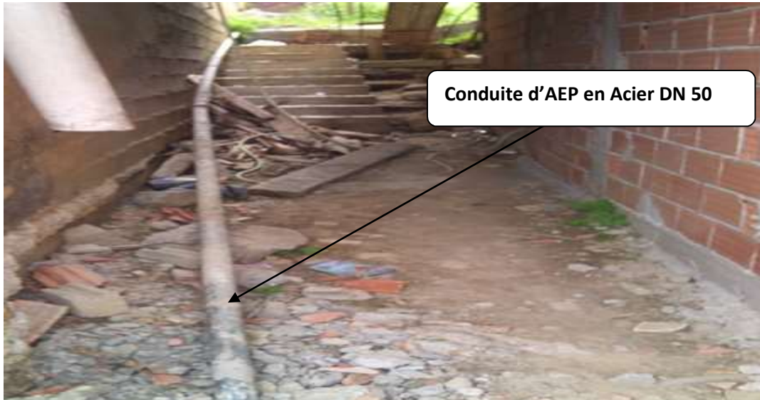
Figure III – 3: état de la conduite DN 50 en acier a la cité les eucalyptus
