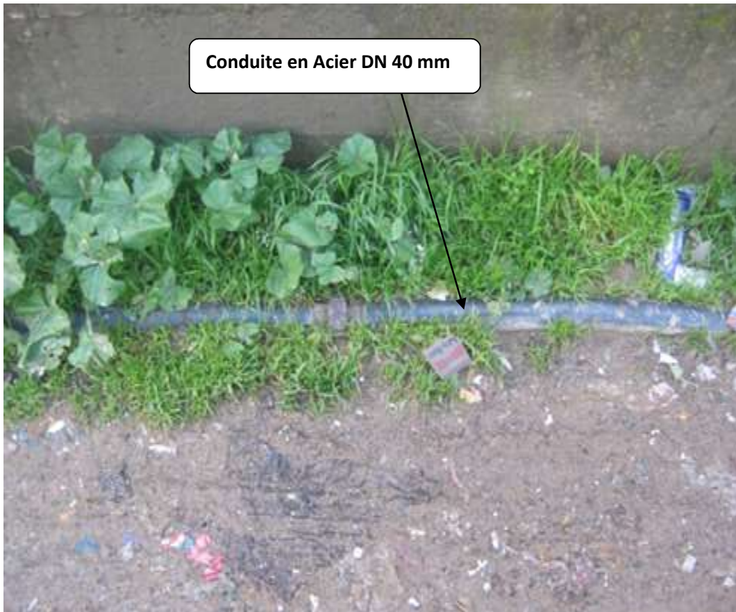
Figure III – 1: état de la conduite DN40 a la cité des 30 logements
