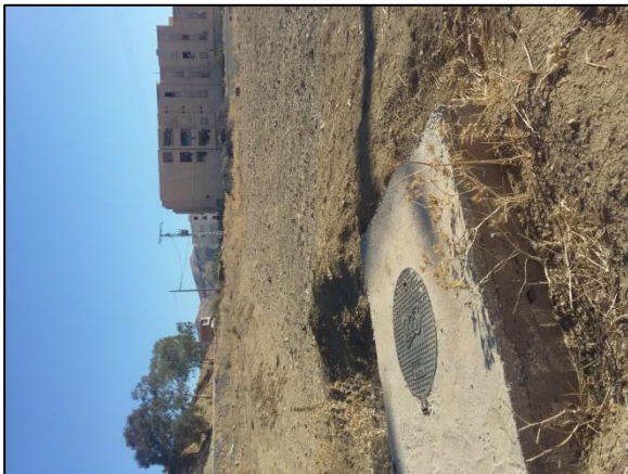
Figure III.25 : Vanne de branchement au niveau de la Conduite d'adduction de 200mm. Fraction Oulad SAYFIA, En bonne état.
