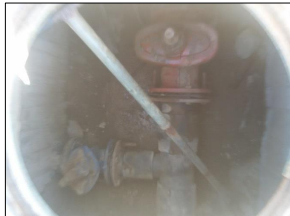
Figure III.26 : Chambre de vanne 02. En bonne état.
