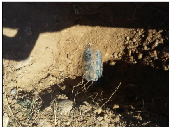
Figure III.18 : Conduite de distribution de 160mm de diamètre, R200, vers nœud N72. En bonne état.
