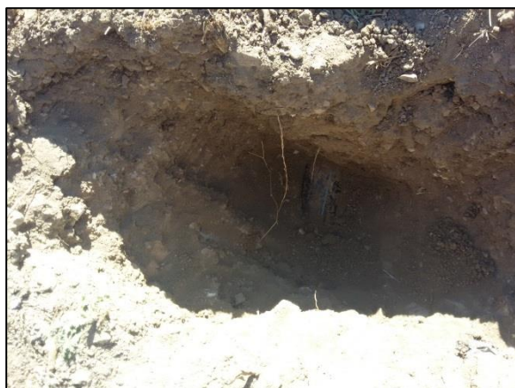
Figure III.12 : Conduite d'adduction vers R200, PEHD de 110mm de diamètre et de 636 ml de longueur. En mauvaise état.
