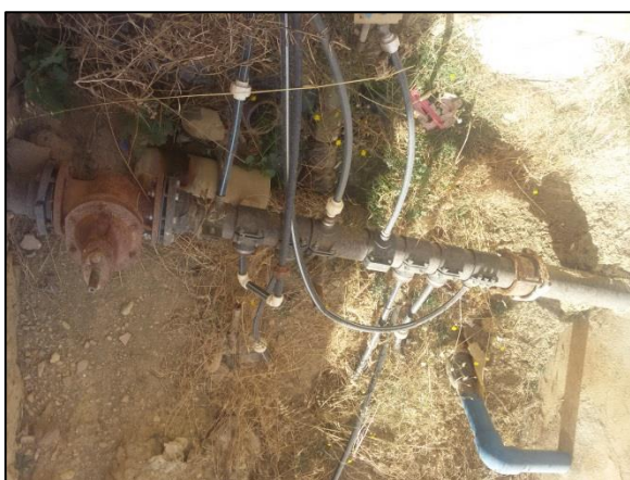
Figure III.13 : Branchements illicites dans la conduite de vidange de R100.
