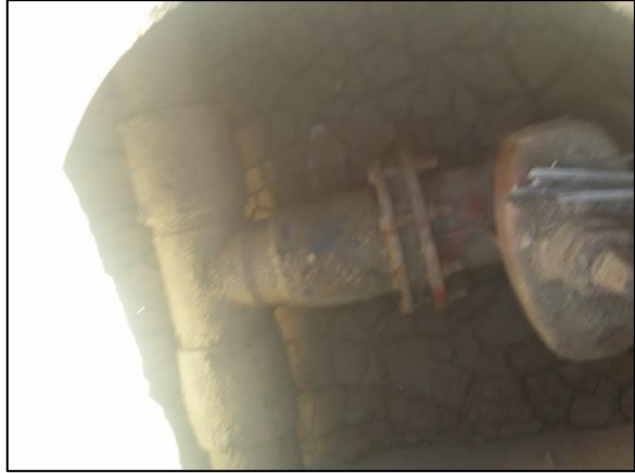
Figure III.24 : Vanne de vidange au la Conduite d'adduction de 200mm. En bonne état.
