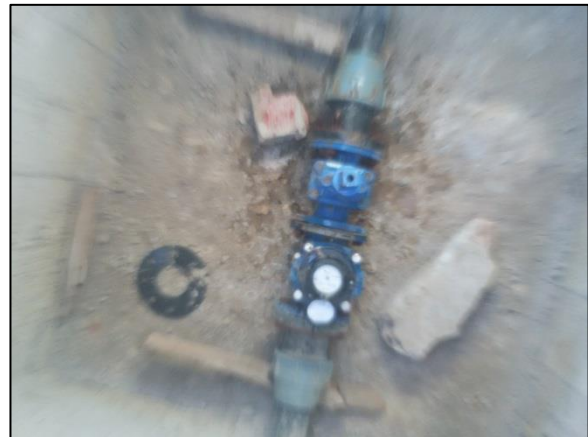
Figure III.25 : Vanne de branchement au niveau de la Conduite d'adduction de 200mm. Fraction Oulad SAYFIA, En bonne état.
