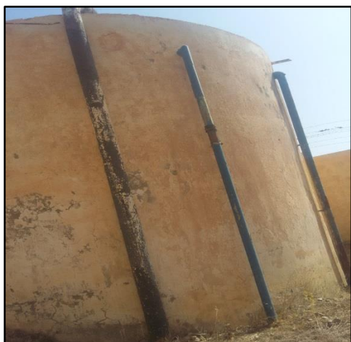
Figure III.14 : R100 M 3 avec un mur fissuré qui engendre des fuites
