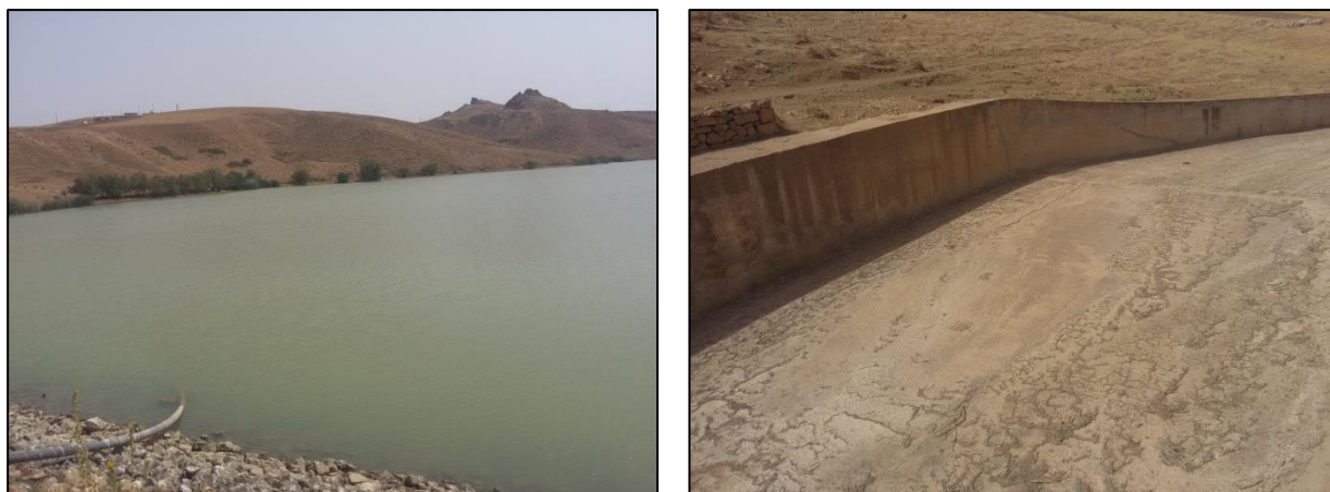
Figure III.2 : Barrage d'OUED R'HOUB ; Un barrage, de 10 m de hauteur au-dessus du lit, qui donne origine à une retenue de 900000m 3 de volume 75% de vieillissement.
