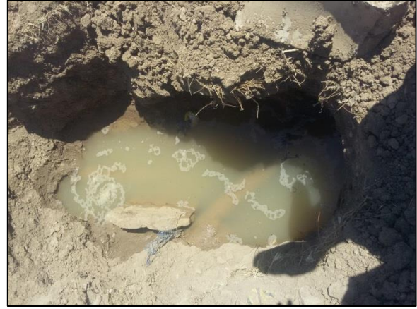
Figure III.21 : Fuite à la Conduite de distribution R100.
