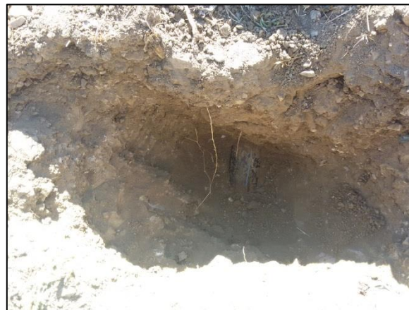
Figure III.12 : Conduite d'adduction vers R200, PEHD de 110mm de diamètre et de 636 ml de longueur. En mauvaise état.
