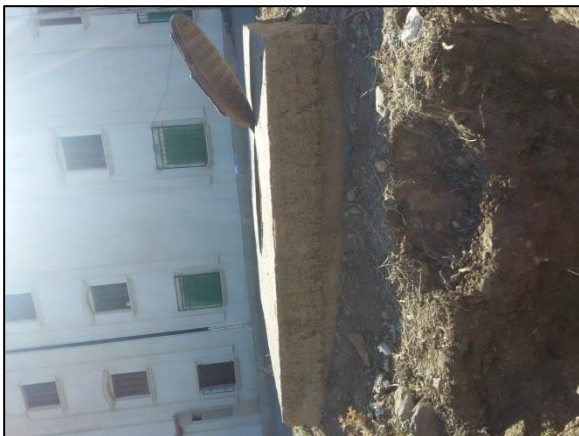
Figure III.26 : Chambre de vanne 02. En bonne état.
