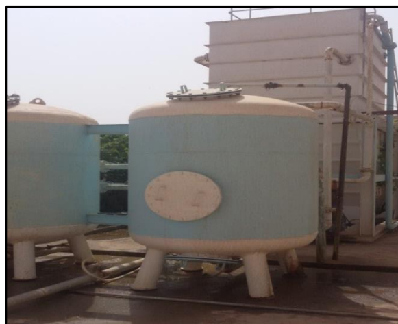
Figure III.8 : Une station de traitement mono bloc, de 10 l/s de capacité
