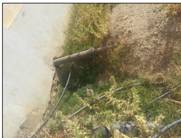
Figure III.13 : Branchements illicites dans la conduite de vidange de R100.
