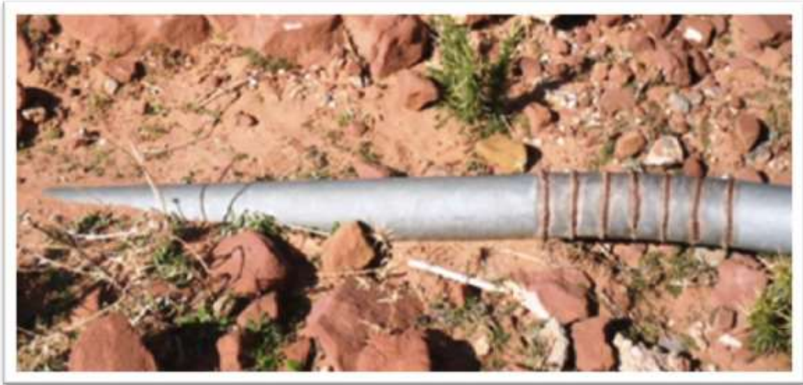
Figure I.4 Réparation non conforme le forage 04 ( F04) - Source : BEHG - 2010 .
