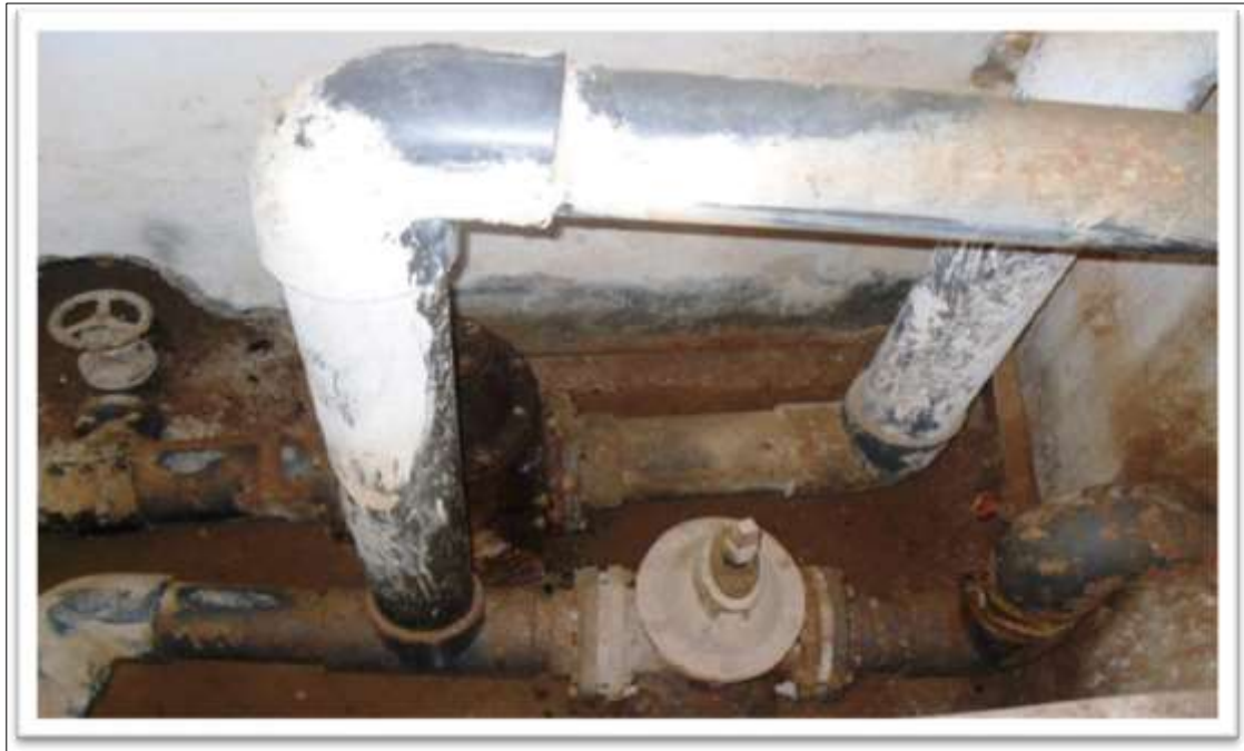
Figure I.8: Etat des équipements hydromécaniques (Chambre des vannes R02)- Source : BEHG – 2010.
