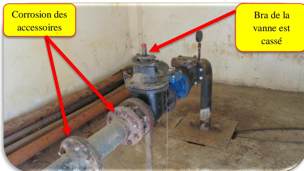
*Figure III.1 : Conduites et pièces spéciales forage F1 (DRE Blida, Avril 2019)*
