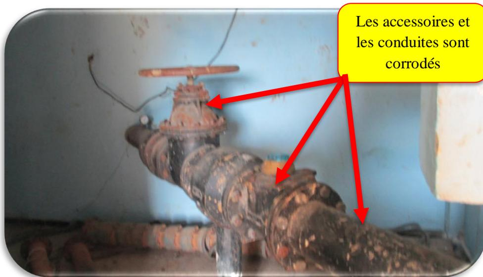
*Figure III.7 : Conduites et pièces spéciales forage F3 (DRE Blida, Avril 2019)*
