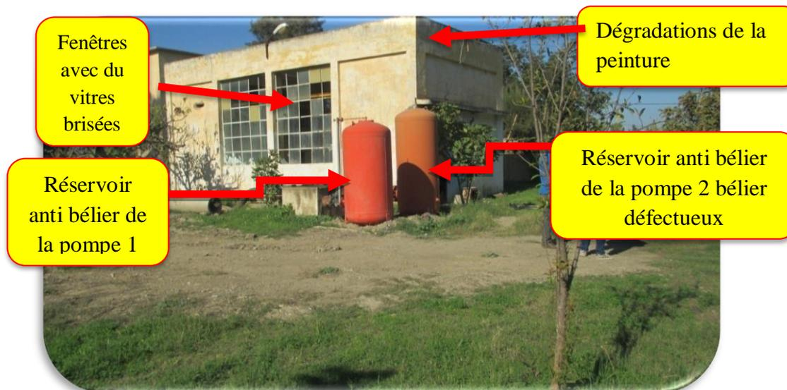
**Figure III.14 : Vue de face de la Stations de pompage (DRE Blida, Mars 2019)**
