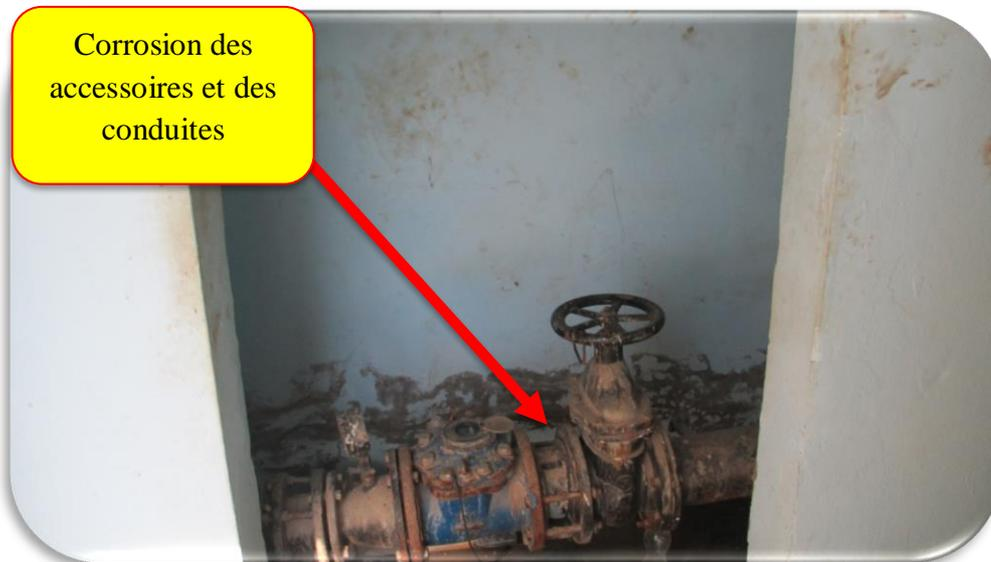
*Figure III.8 : Conduites et pièces spéciales forage F4 (DRE Blida, Avril 2019)*
