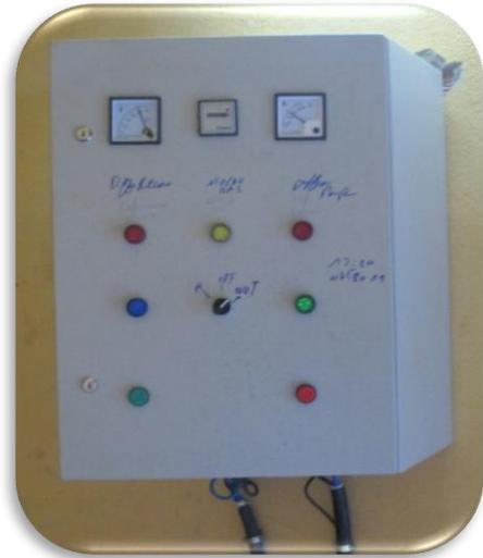
**Figure III.12 :** Armoire de commande du forage F7 (DRE Blida, Avril 2019)
