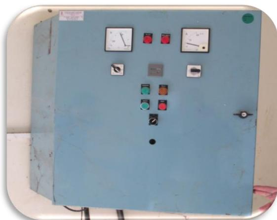
*Figure III.6 : Armoire de commande du forage F3 (DRE Blida, Avril 2019)*
