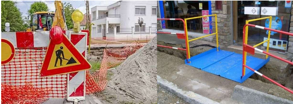
Figure VI.3 – Dispositifs de protection collectives
