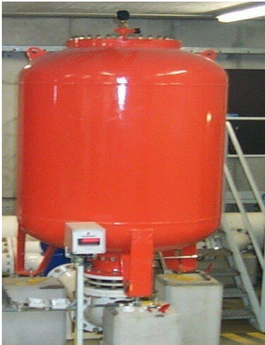
Figure 6-III : le réservoir d'air.(6)
