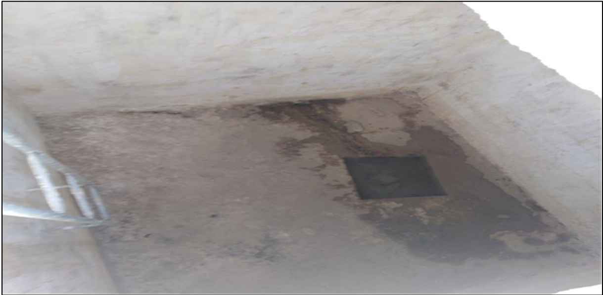
Figure IV. 9 : Photo de l'intérieur du captage (BET.Tissemsilt) (13.01.2021)
