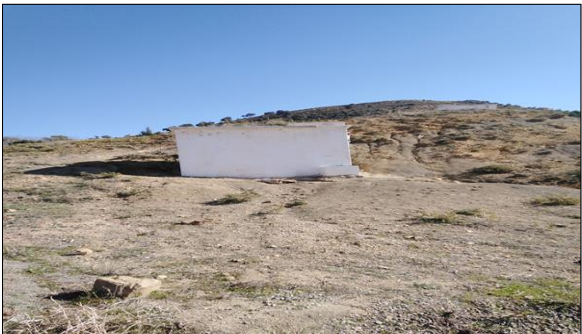
Figure IV. 7 : Bâche de 18 m 3 (BET.Tissemsilt) (13.01.2021)
