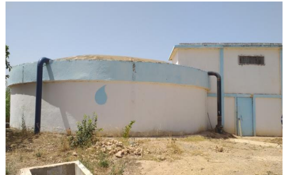
Figure N° VII.2. Réservoir 400m 3
