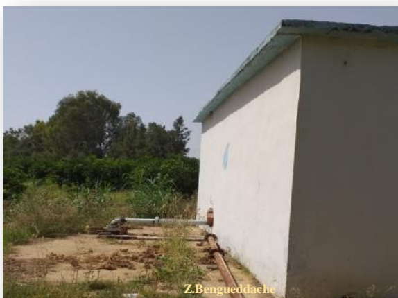
C. La conduite de refoulement
