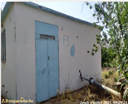
A. L'extérieur de l'abri de forage
