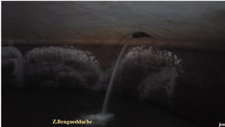
A. l'intérieur du réservoir
