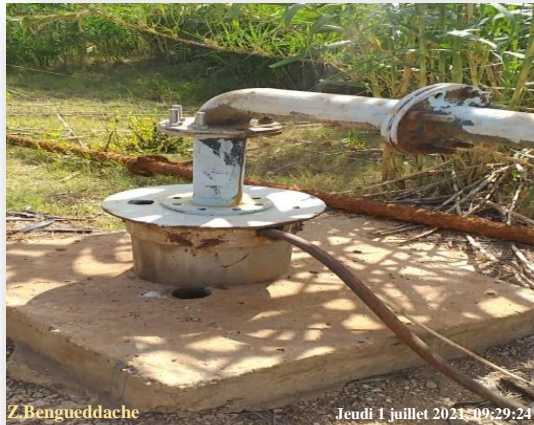
A. Le forage
