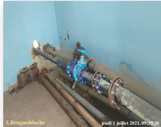
B. La conduite de refoulement
