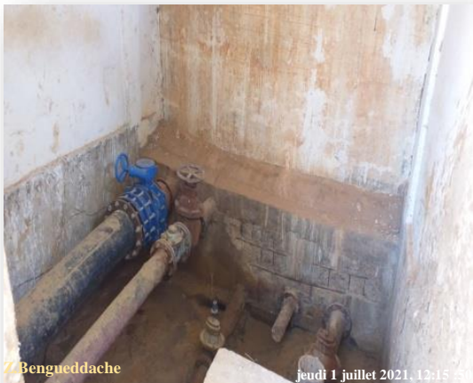
D. la chambre de vanne
