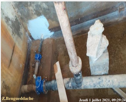
A. La chambre de vanne
