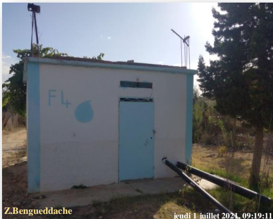
A. L'extérieur de l'Abri de Forage
