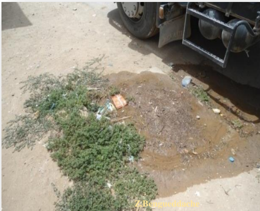
Exemple de Fuite sur le réseau d'AEP du centre d'El H'madna
