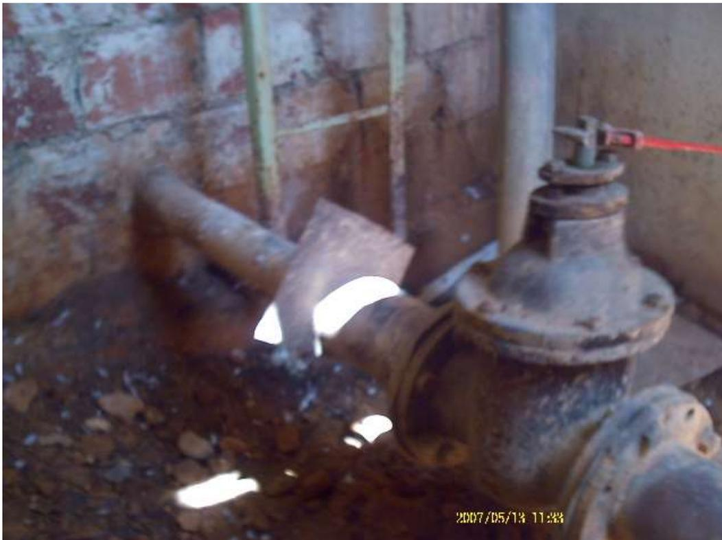
**Figure IV-3:** Vanne d'adduction-Source: DRE W.AINDEFLA 2007
