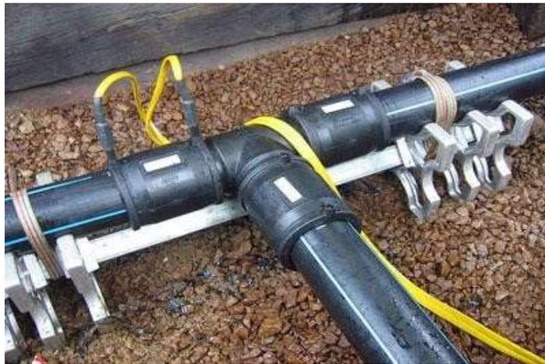
**Figure VI-2:** Electro soudage des tubes en PEHD.
