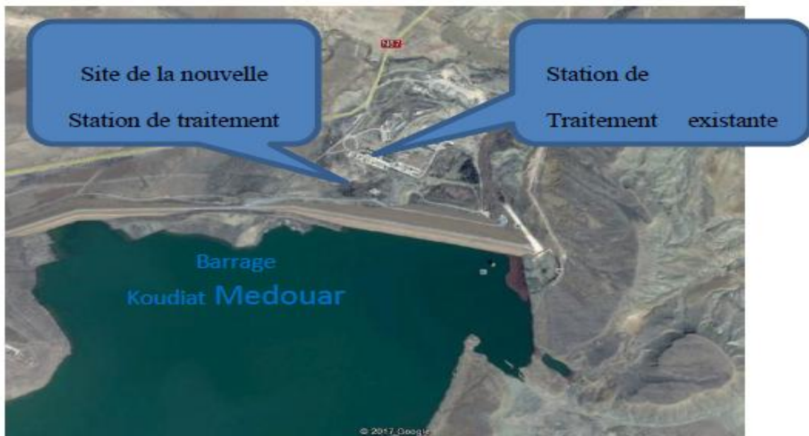
Figure I.6 : Localisation du site de la station de traitement
