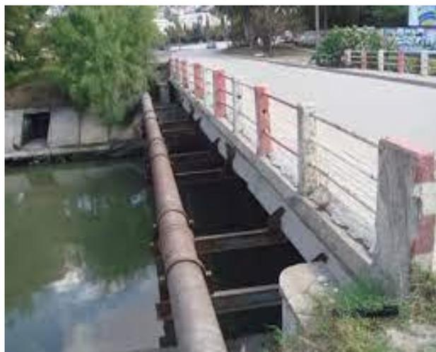
**Figure IV-18: Premier cas - soutenir le passage de la conduite par le pont**
