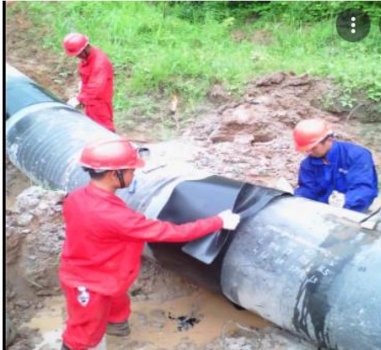
**Figure IV-32 : Protection de la conduite en fonte contre la corrosion extérieure avec revêtement en polyéthylène**
