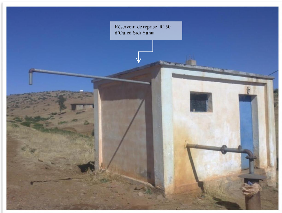
Figure I.19 : Réservoir d'Ouled Sidi Yahia de 150m 3
