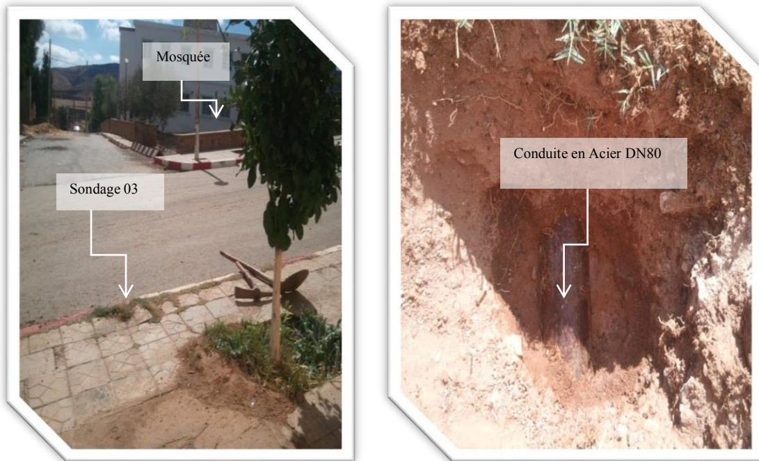
Figure I.22 : Sondage N°3 du réseau existant
