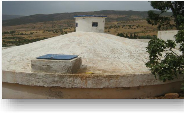
Figure IV.12 : Reservoir semi enterée de capacité 500 m 3 (DRE ain defla, 2021)
