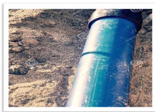
Fig III.5. conduite en pehd en bon état classe PN16(DRE 2021)
