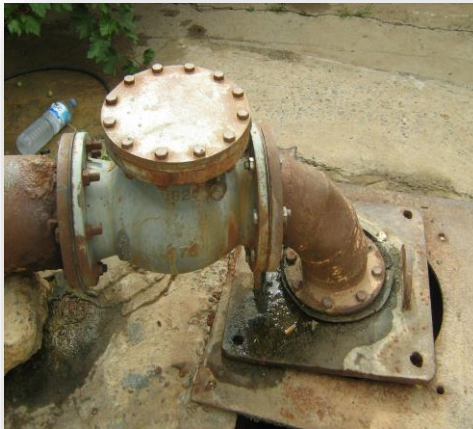
Figure III. 8 : Tête de Forage & clapet anti - retour(DRE Ain defla ,juin 2020
