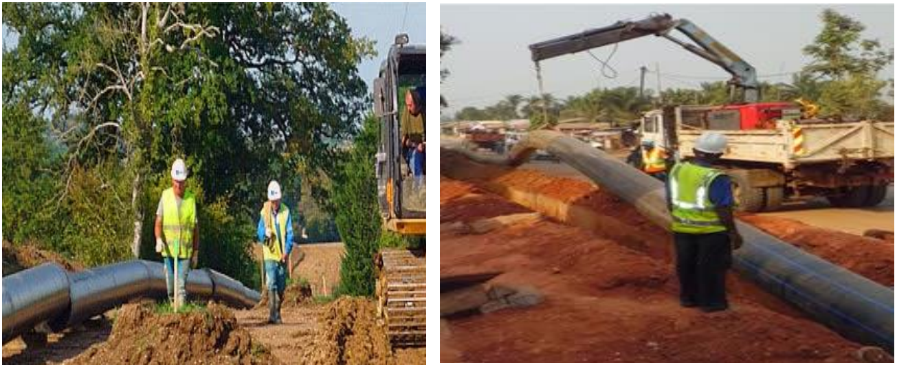
Figure VI.2 :Pose des canalisations en tranchée ouverte (google 2021)
