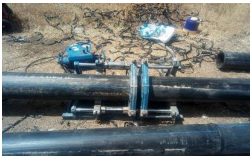
Figure VI.3 : Assemblage Bout à bout
