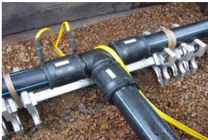
Figure VI.4 : Assemblage PEHD par électro-soudage
