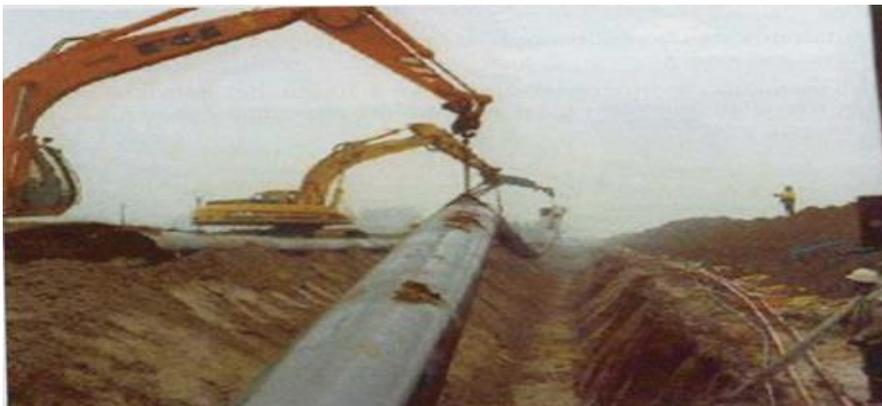
**Figure N°VII.3: Pose des conduites en PEHD dans les tranchées**
