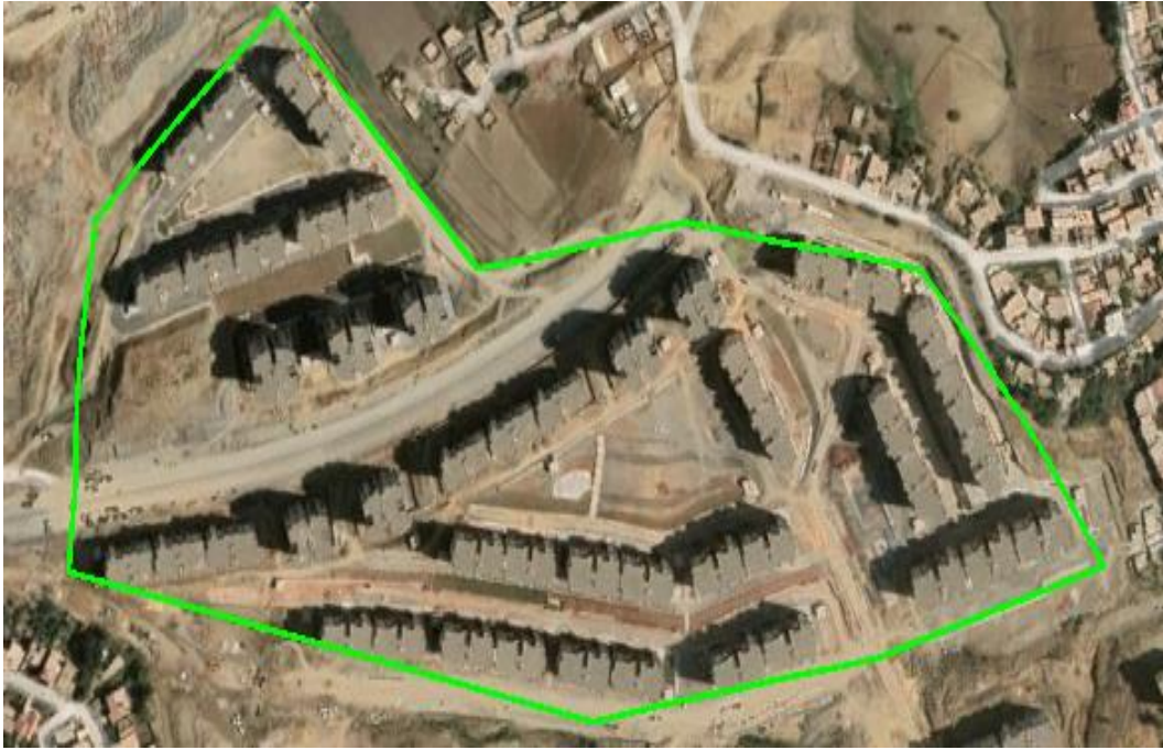
Figure I-4: image satellite non traitée de la zone d'étude au niveau de la nouvelle ville Sidi Abdallah.
