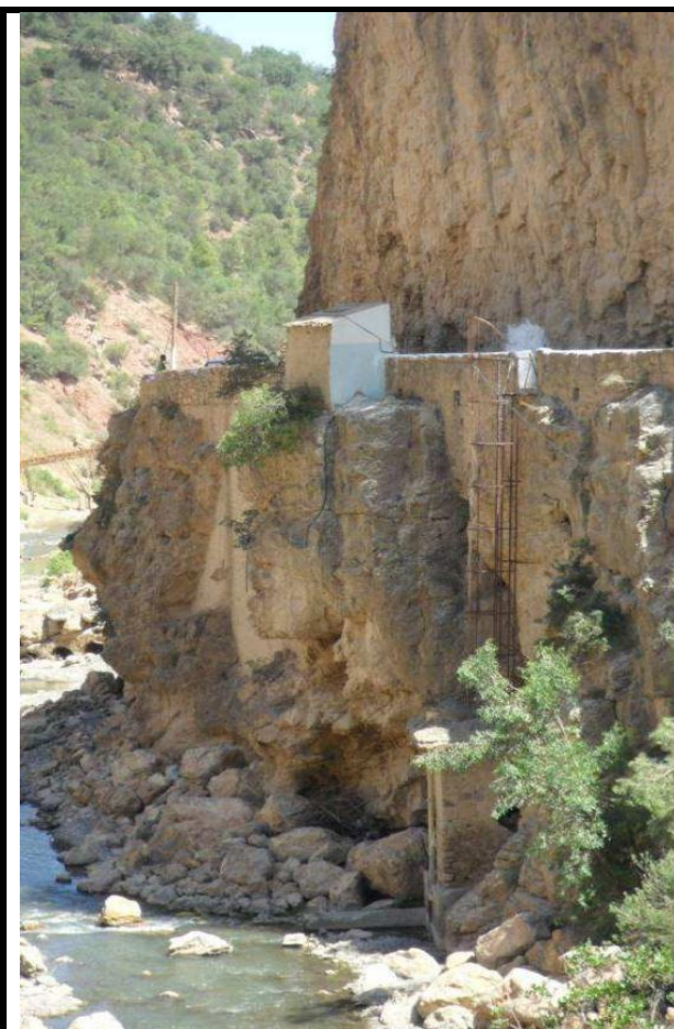
Figure 68 : l'ancienne station de Rocher de Pigeon (1979-2001)
