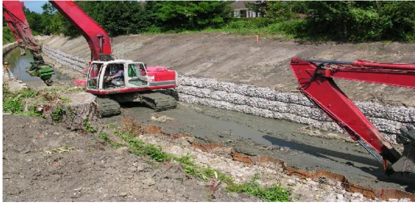
Figure III-13 : Exemples de réalisation d'un mur en gabion
