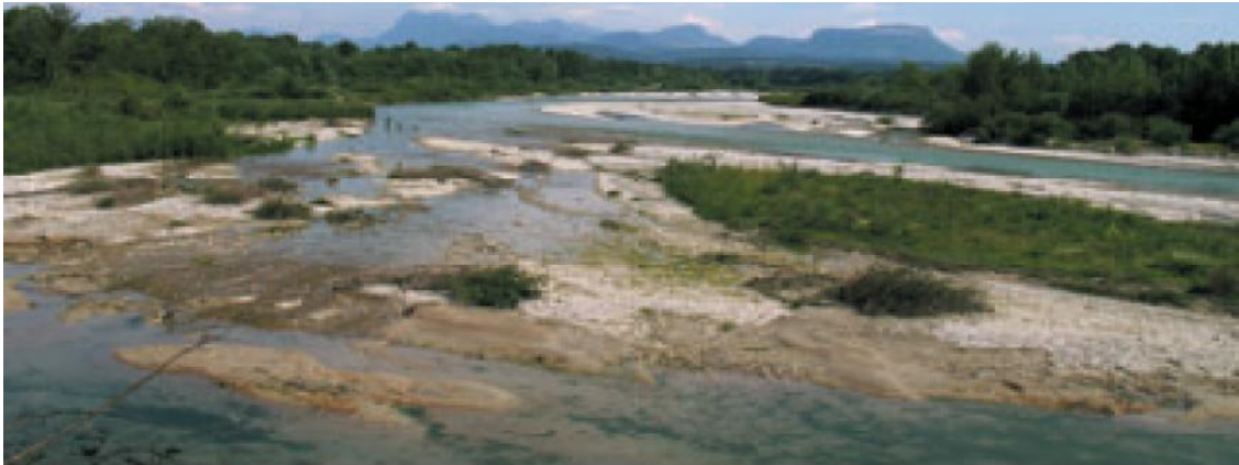
Figure I-6: Exemples de morphologie de cours d'eau, des sources vers la mer. De haut en bas : l'Ain (Jura) rivière de tête de bassin à lit en gorge ; la Hulle (Ardenne) rivière de zone intermédiaire à lit sinueux ; la Touques (Calvados) rivière de plaine à lit méandriforme ; la Drôme (Drôme) rivière de plaine à lit en tresse.
