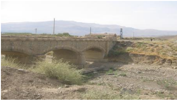
a)-Chemin de fer qui traverse l'oued
