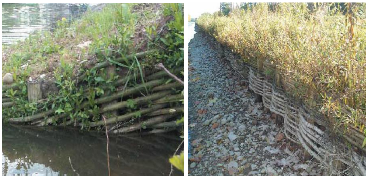
Figure III-6 : exemple de tressage réalisé
