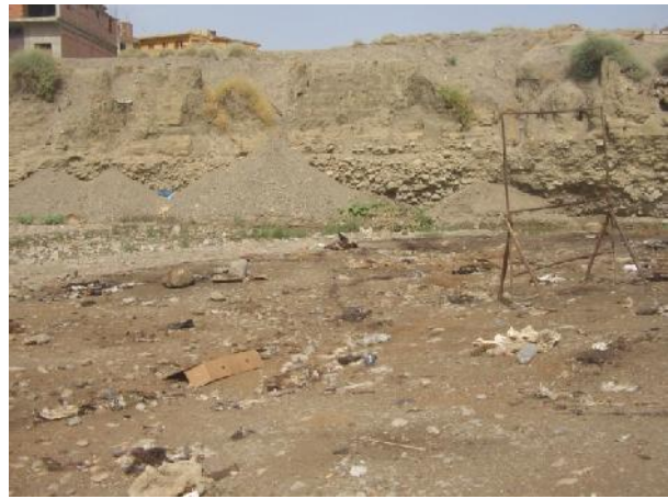
b)- degradation des berges
