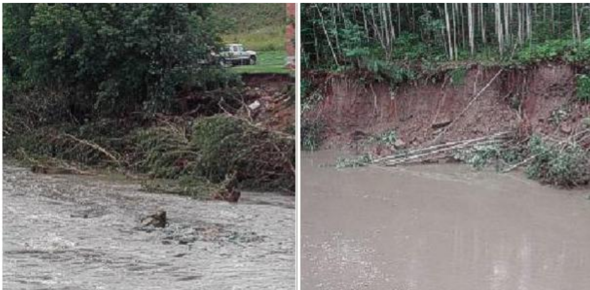
Figure I.11 Érosion des berges par le cours d'eau d'une rivière.
