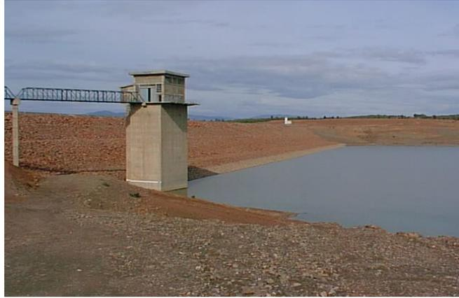
**Figure II.8 :** Prise agricole et la tour de prise du Barrage (ANBT)
