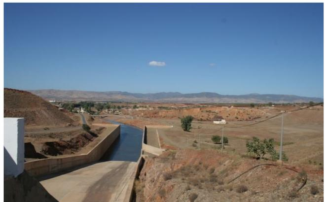
**Figure II.6 :**Evacuateur de crues du Barrage OuledMellouk(ANBT)
