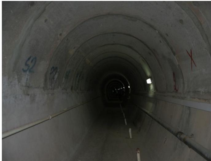
**Figure II.9 :** Galerie d'injection et drainage du Barrage (ANBT)
