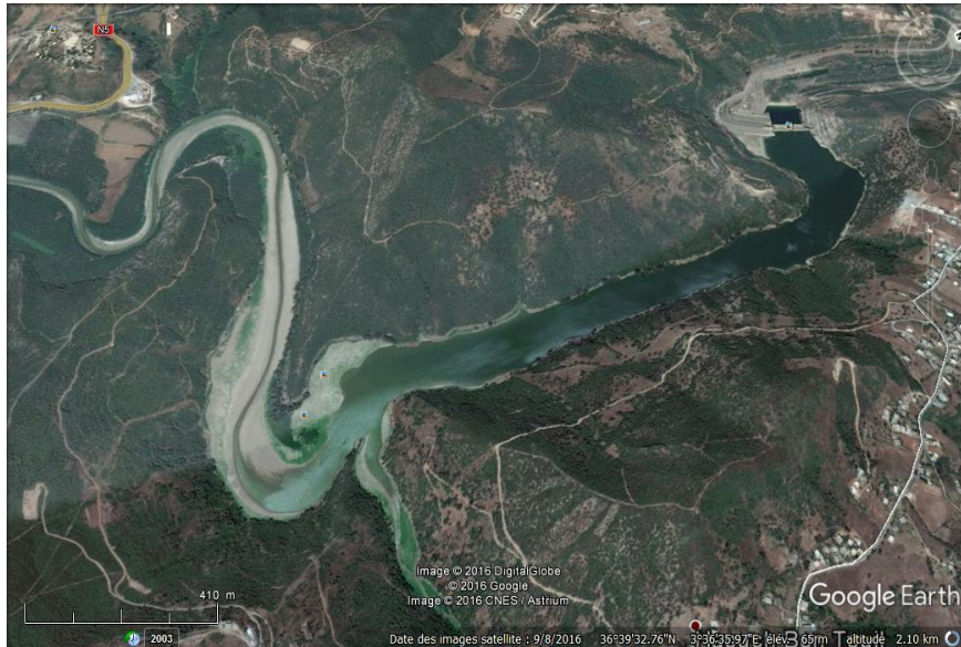
Figure 2.2 : Image satellite non traitée du barrage de Béni Amrane
