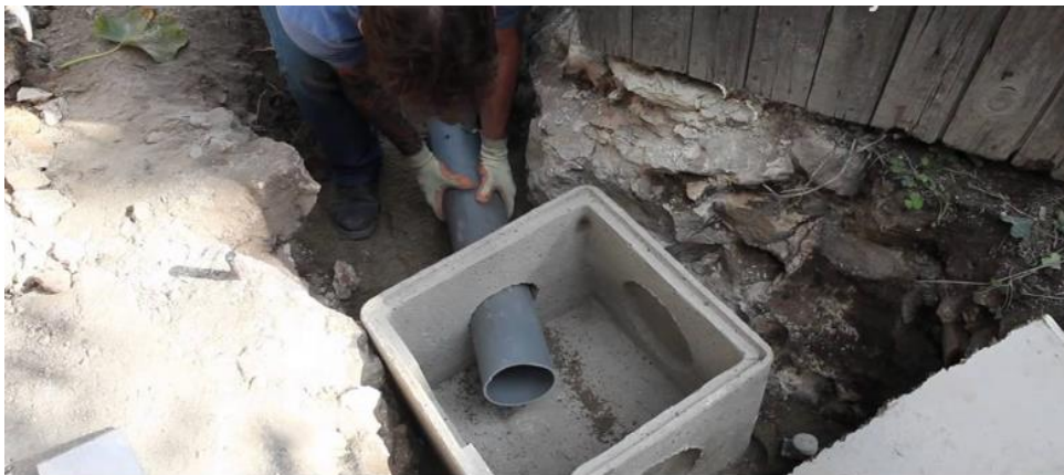
Figure I.10 : Installation d'un regard de visite.
