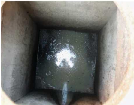
Figure I.8 : Regard en bon état (10/11 2016)
