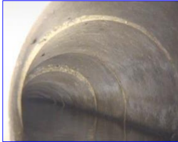
Fig IV.6 : Vue amont de la conduite en Béton DN300
