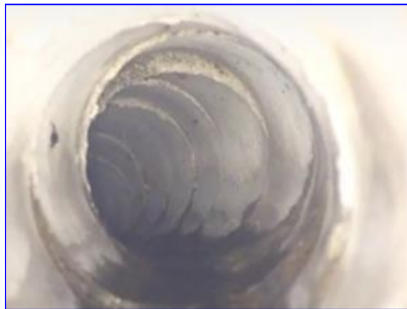
FigIV.7 : amont de la conduite en Béton DN 300
