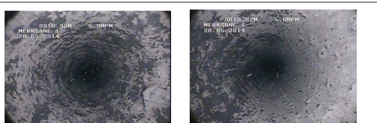
Figure IV.08 : Auscultation du forage de MERKSANE à la partie profondeur 10,90m a 12,82m. (DRE Illizi, 2014).
