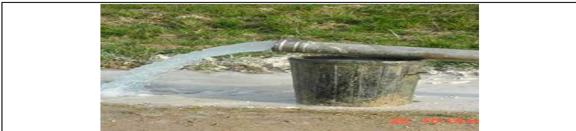
Figure III.01 : Aspect d'eau avant la réhabilitation. [1]
