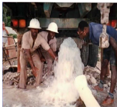
Figure I.03 : Un forage artésien jaillissant réalisé à Formon, dans le Sud de Haïti. (Haïti, 1992)
