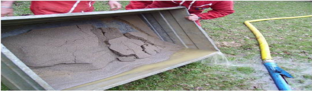
Figure III.17: sable accumulé au fond du forage s'est déposé dans le bac de décantation.(O. Dureau, 2007).
