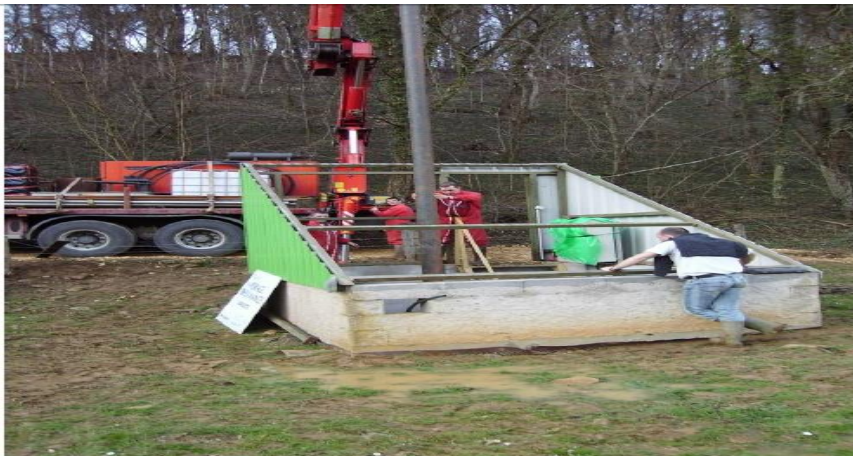
Figure III.18 : Remise en service de la colonne de refoulement. (O. Dureau, 2007).
