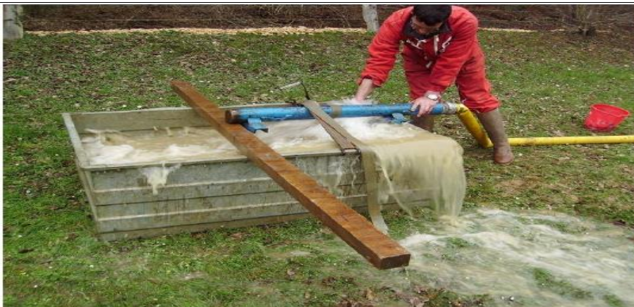
Figure III.11: récupération du mélange eau, air et dépôts lors du nettoyage par air lift. (O. Dureau, 2007).
